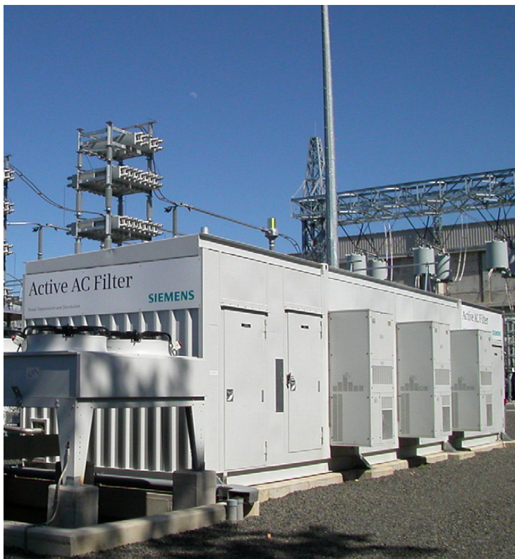
Fig. 1.13 – Exemplo de filtro ativo com conversores multiníveis.
