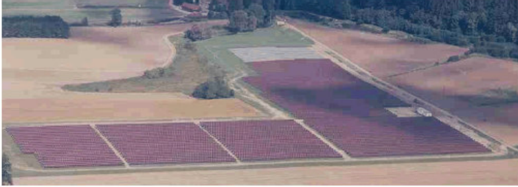
Fig. 1.5 – Vista de uma planta de 1 MW de geração de energia com painéis fotovoltaicos [17] (Alemanha).
