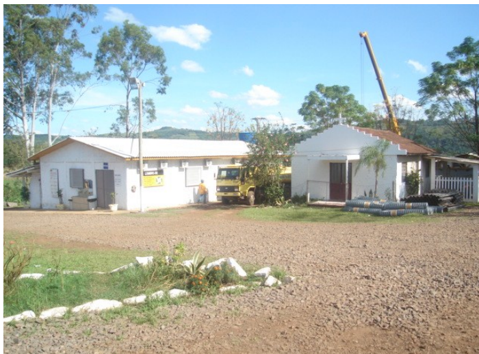
Figura 22: Capela e Salão Comunitário da antiga localidade de Saltinho do Uruguai, desapropriada para a instalação do canteiro de obras. Fonte: Consórcio Foz do Chapecó Energia, maio de 2009.
