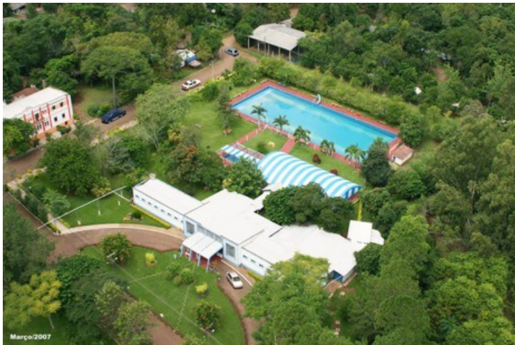
Figura 28: Imagem aérea da Sede do empreendimento Thermas de Ilha Redonda. Fonte: www.ilharedonda.com.br em abril de 2011.
