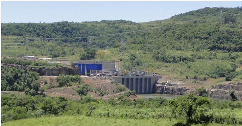
Figura 50: Casa de força da usina hidrelétrica Foz do Chapecó Energia. Fonte: arquivo pessoal.
