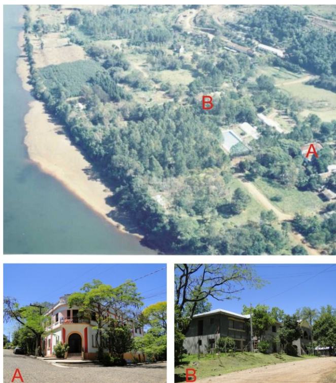
Figura 38: Imagem aérea da localidade de Ilha Redonda na década de 80, marcando a implantação do Hotel Gloria (B), construído na década de 50 e ainda em atividade e Grande Hotel (A), que após um período sem atividade, atualmente encontra-se em reforma. Fonte: Arquivo pessoal.
