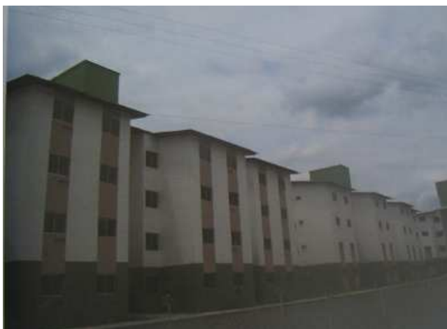
Figura 5 – Vista Lateral do Residencial D
