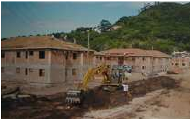
Figura 2 – Residencial B em Fase de Construção – Infra-Estrutura
