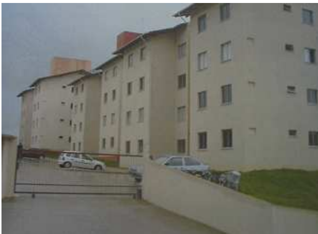
Figura 7 – Vista frontal da fachada do Residencial E
