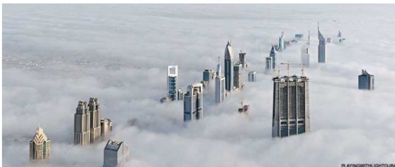
Figura 13 - Rachaduras no Paraíso
