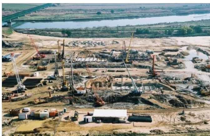
a) Aspeto geral da obra
