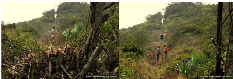
Figura 04: cerca sendo instalada em área de Restinga preservada sobre as paleodunas dos Areais da Ribanceira de Imbituba/SC.
