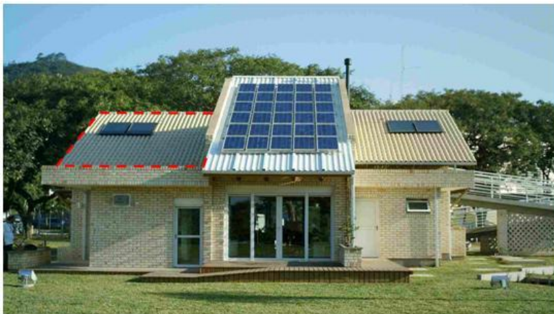
Figura 5.28 – Vista da fachada Norte, destacando-se a cobertura do quarto de casal.
