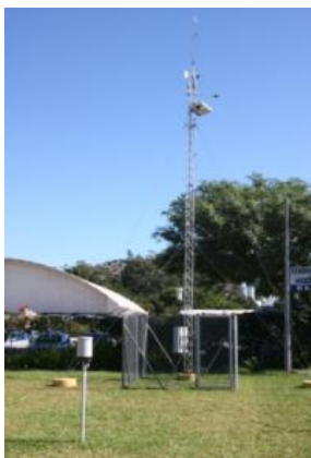
Figura 4.2 – Estação meteorológica LMBEE/Casa Eficiente.
