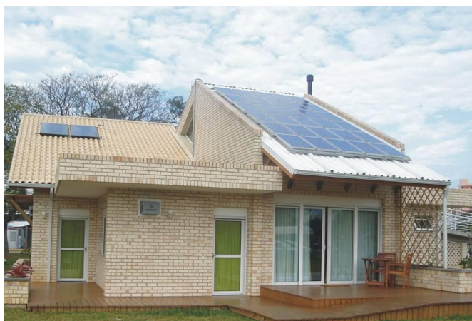
Figura 2.8 – Vista externa da Casa Eficiente (fachada Norte).
