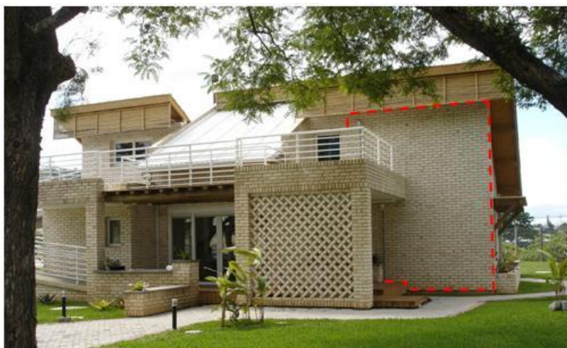
b) Fachada Sul
