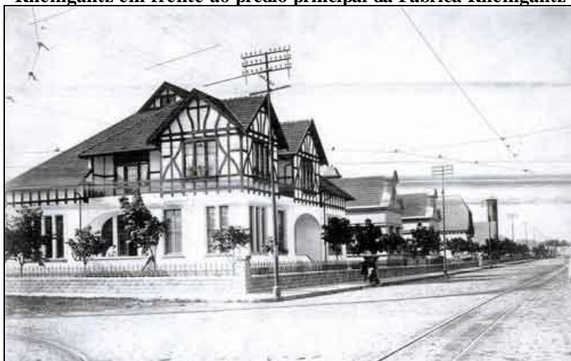
Foto 1: Rio Grande/RS: Cassino dos Mestres na atual Avenida Rheingantz em frente ao prédio principal da Fábrica Rheingantz
