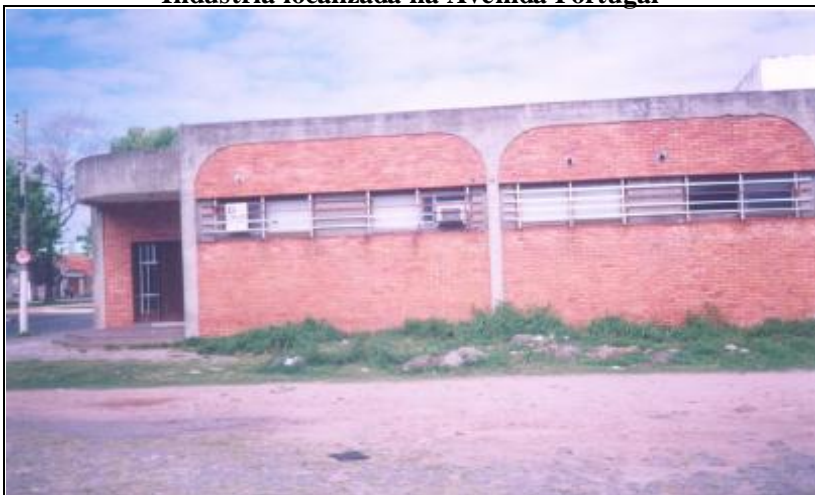
Foto 5: Rio Grande/RS: Fachada fábrica Furtado S.A. Comércio e Indústria localizada na Avenida Portugal
