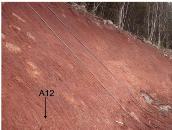
**Figura 64** – Vista da última banquetta do taludamento realizado na encosta, antes da colocação do sistema de drenagem, observando-se a presença de material aparentemente de natureza coesiva.
