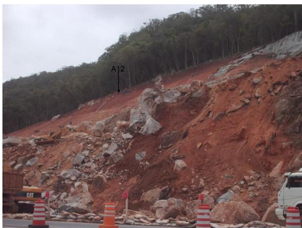
**Figura 63** – Vista lateral esquerda da encosta, onde se observa matacões, afloramentos do granito Ilha e grande quantidade de materiais granulares.
