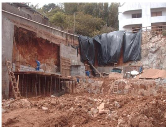
**Figura 69** – Visão geral das escavações e da construção da estrutura de contenção.
