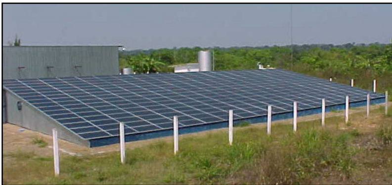
Figura 67: Vista do gerador FV de 20,48 kWp instalado na vila de Araras, em Rondônia.
