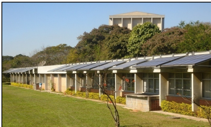
Figura 9: Vista do prédio da administração do IEE – USP, no qual o SFCR de 12,3 kWp foi instalado em 2001 e ampliado em 2003.
