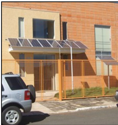
Figura 40: Painel FV de 1,04 kWp do SFCR da empresa SOLARIS em Leme – SP.
