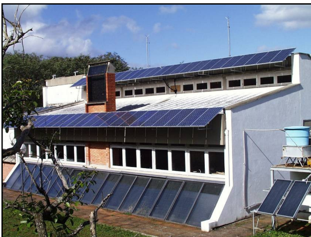
Figura 22: Vista geral do prédio do Laboratório de Energia Solar da UFRGS, no qual foi instalado o SFCR de 4,8 kWp.
