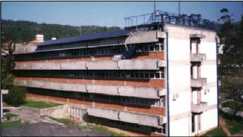
Figura 5: Vista geral do prédio do departamento de engenharia mecânica da UFSC, na cobertura do qual foi instalado o SFCR de 2,02 kWp do LABSOLAR.
