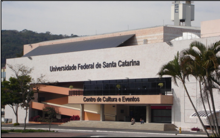
Figura 20: Vista geral do prédio do Centro de Cultura e Eventos da UFSC no qual foi instalado o SFCR de 10,24 kWp.
