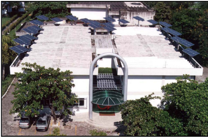
Figura 11: Vista geral do prédio do CEPEL, no qual o SFCR de 16,32 kWp foi instalado.
