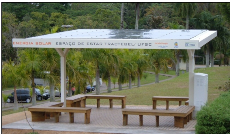
Figura 53: Vista geral do SFCR de 1,99 kWp do Colégio de Aplicação / TRACTEBEL / UFSC.
