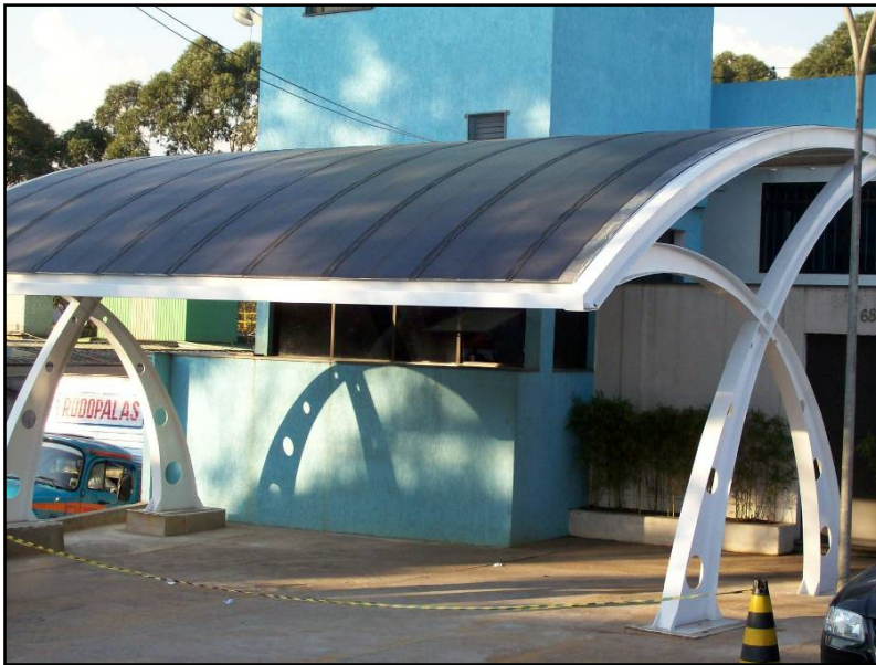
Figura 42: Vista geral do painel FV do sistema de 2,45 kWp da Motor Z.
