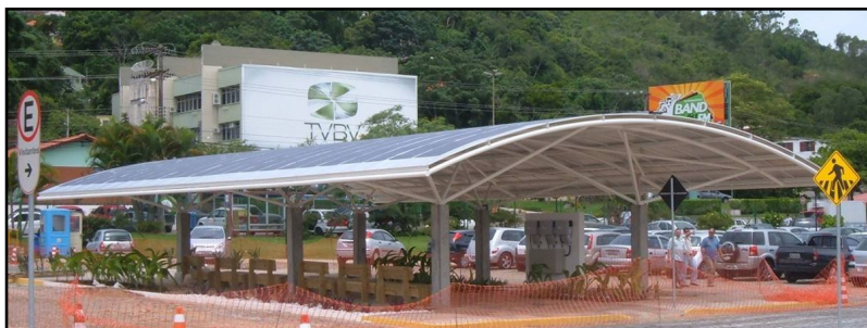
Figura 50: Vista geral do SFCR de 11,97 kWp da ELETROSUL.
