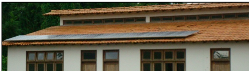
Figura 36: Vista geral do painel FV do sistema de 1,58 kWp do GEDAE / UFPA.
