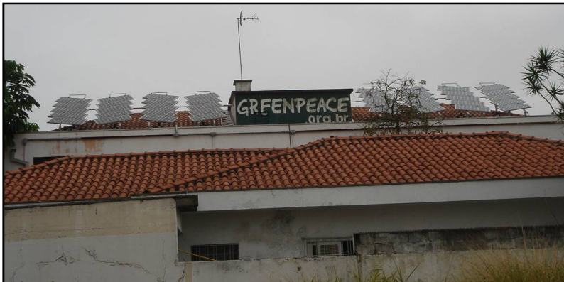
Figura 32: Vista geral do arranjo FV de 2,9 kWp do GREENPEACE.
