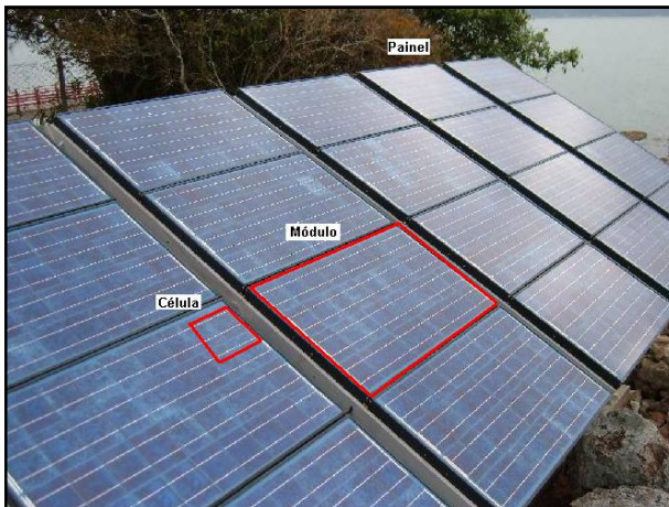
Figura 2: Vista da célula, módulo e painel fotovoltaico.
