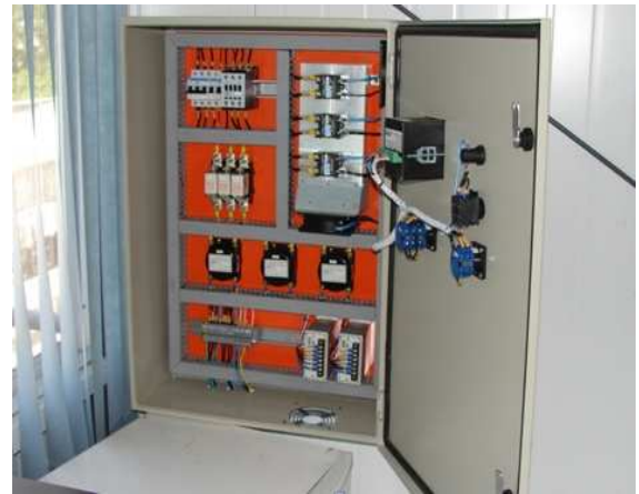
Figura 4.13 – Sistema de controle e medição da potência dissipada pelas resistências.
