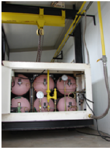
Figura 4.2 - Feixe de cilindros para suprimento de GNC
