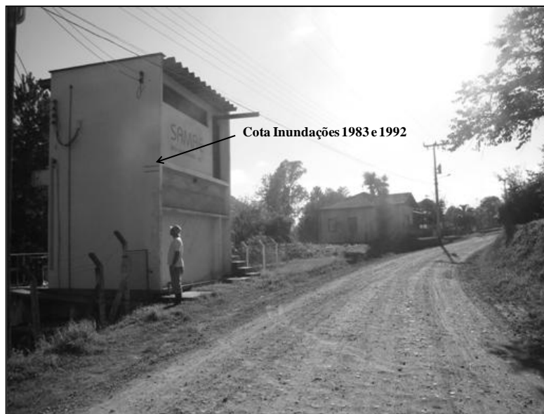
Figura 5.5 – Marca das inundações de 1983 e 1992.
