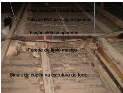
Foto 19: Forro visto por cima (sob o telhado)
