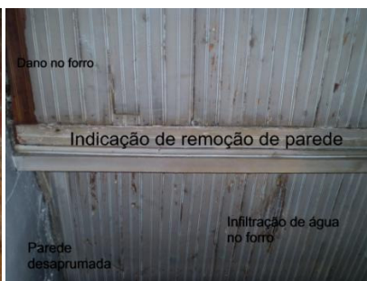
Foto 4: Detalhe do forro do 1º Pav.
