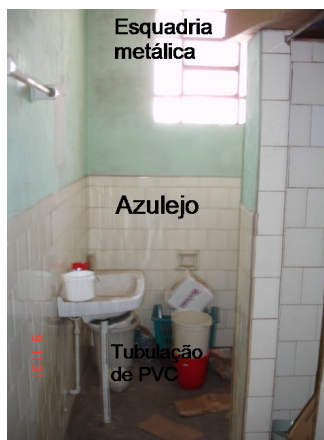
Foto 22: Detalhes do banheiro
