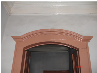
Foto 15: Detalhe de porta interna
