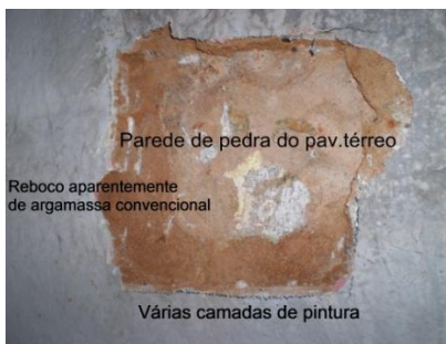
Foto 22: Prospecção em parede do pav. térreo
