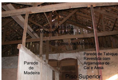
Foto 24: Cobertura vista de baixo
