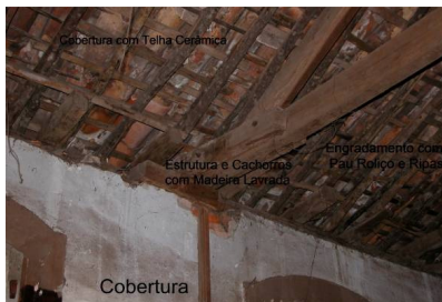
Foto 14: Junção cobertura - alvenaria
