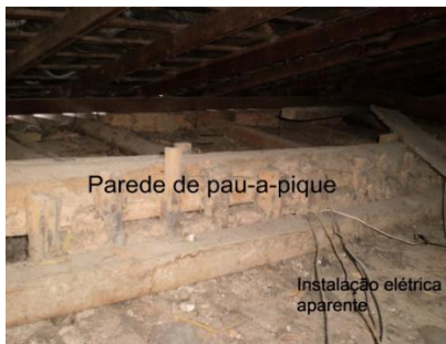
Foto 20: Detalhes da parede de pau-a-pique vista por cima (sob o telhado)
