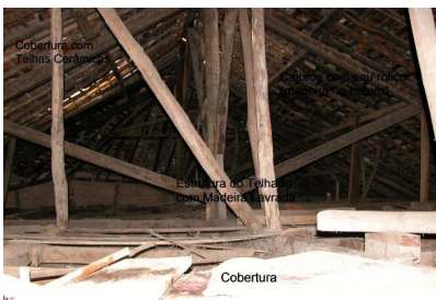
Foto 12: Vão entre forro e cobertura
