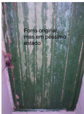
Foto 24: Detalhe do forro do 1º Pav
