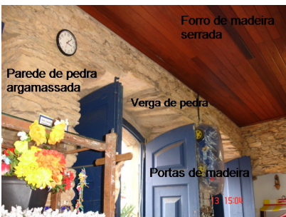
Foto 5: Vista interna do pav.térreo
