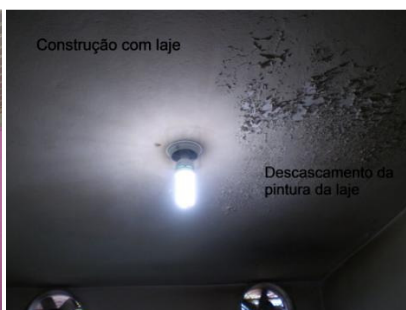
Foto 6: Vista interna do 1º pav.com intervenção
