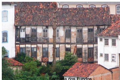
Foto 2: Fachada dos fundos
