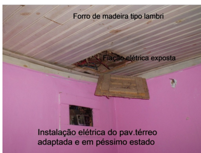
Foto 5: Vista interna do pav. térreo
