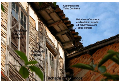
Foto 7: Fachada dos fundos
