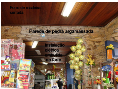
Foto 6: Vista interna do pav.térreo
