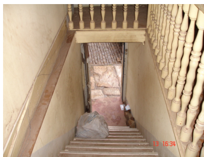
Foto 10: Acesso da rua ao pavimento 1
