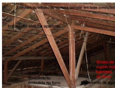
Foto 18: Estrutura do telhado
