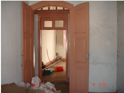
Foto 13: Vista interna do pav.1
