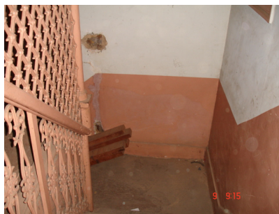
Foto 8: Acesso do térreo ao pavimento 1
