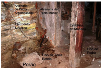
Foto 19: Detalhes do porão
