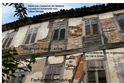
Foto 6: Fachada dos fundos
