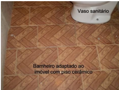
Foto 7: Vista interna do 1º pav. com intervenção
