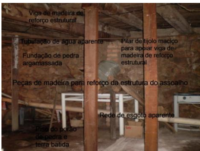
Foto 11: Detalhes do porão - reforço
