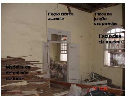
Foto 11: Sala do pavimento 1
