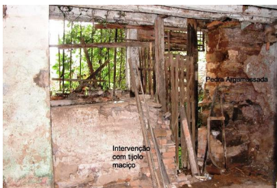
Foto 11: Intervenção no porão
