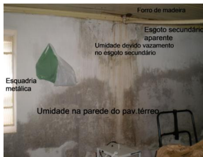
Foto 14: Vista interna do pav.térreo
