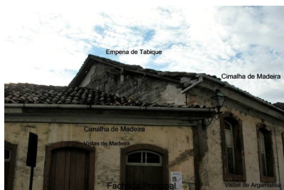
Foto 4: Parte da fachada principal
