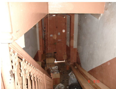
Foto 7: Acesso do térreo ao pavimento 1
