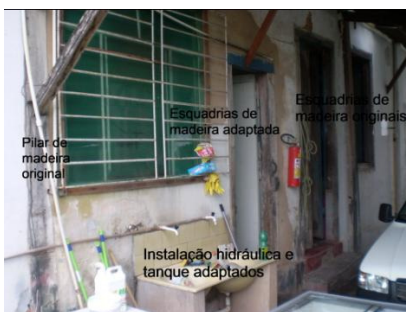
Foto 15: Fachada lateral direita
