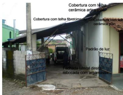
Foto 16: Fachada lateral direita
