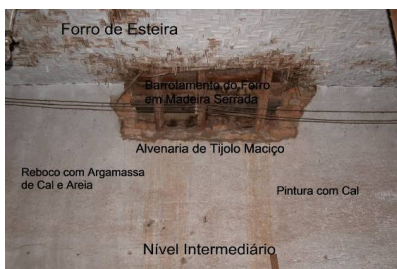
Foto 16: Junção Alvenaria - forro
