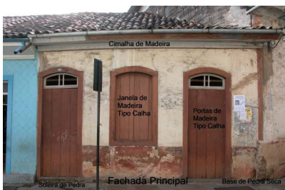
Foto 3: Parte da fachada principal
