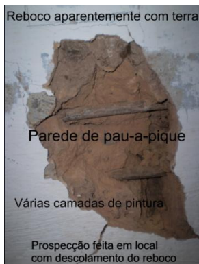
Foto 23: Prospecção em parede do 1º pav.
