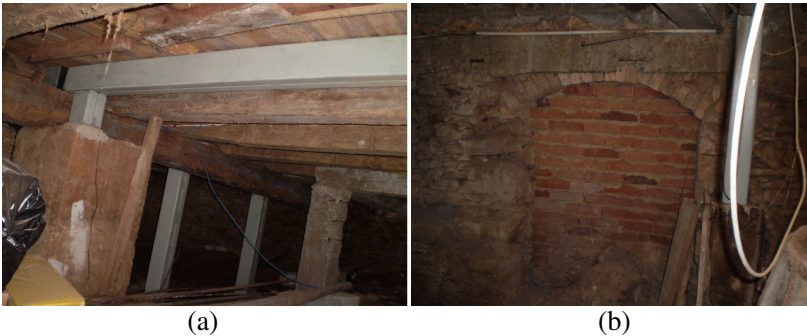
Figura 4: (a) Inserção de vigas e pilares metálicos em obra antiga; (b) fechamento de vão em parede de pedra com tijolo cerâmico.
