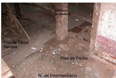
Foto 15: Piso do nível intermediário
