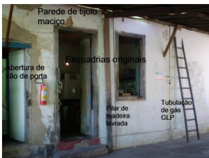
Foto 21: Detalhes da fachada lateral direita
