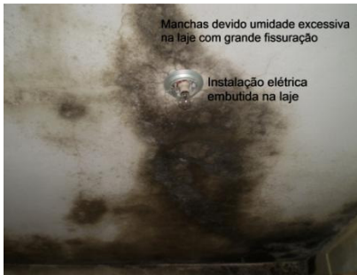
Foto 8: Vista interna do 1º pav. com intervenção
