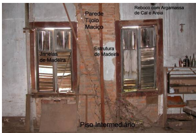
Foto 9: Esquadrias do piso intermediário
