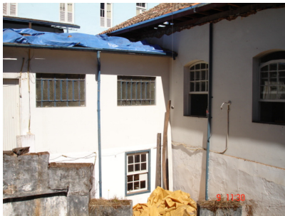
Foto 4: Parte da fachada dos fundos
