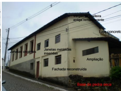
Foto 2: Fachada lateral esquerda e dos fundos
