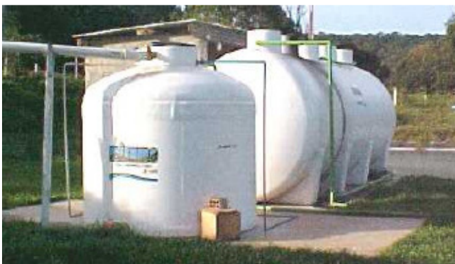
Figura 13 - Sistema de tratamento de efluente sanitário compacto comercial (MISUMO ® ) adaptado ao tratamento de efluentes de um sistema de produção de suínos.
