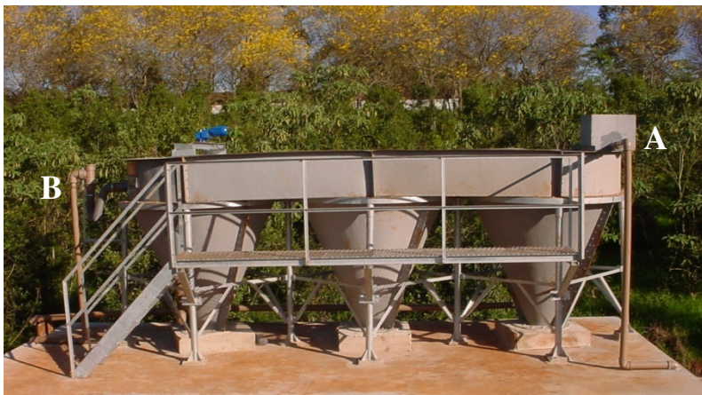
Figura 18 –Flotodecantador da estação de tratamento de dejetos de suínos da Embrapa Suínos e Aves. A, entrada do sistema; B, local onde foi realizada a coleta para alimentação do reator.
