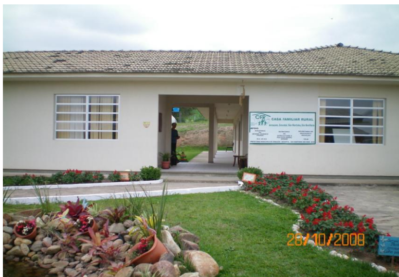
Figura 7: foto da fachada da CFR de Armazém. Fonte: Dados primários.
