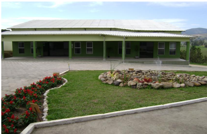
Figura 8: foto da fachada do auditório da CFR de Armazém.
