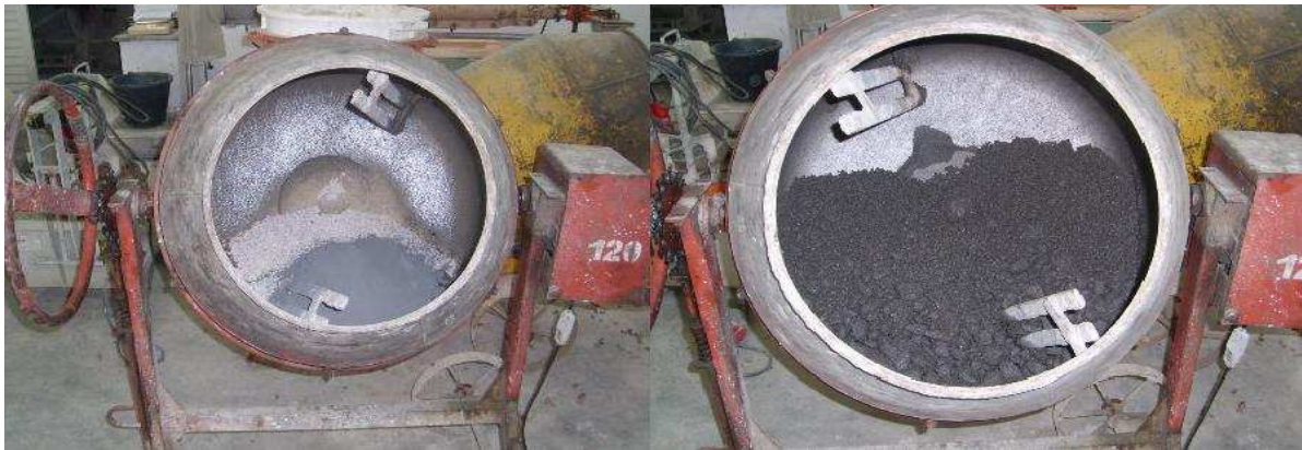
(a) agregados secos na betoneira
