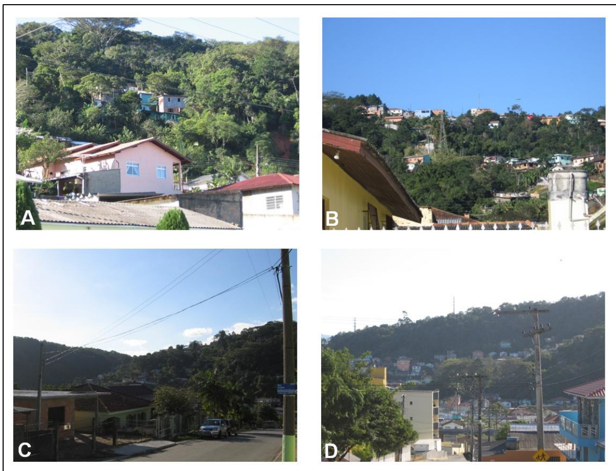
Figura 6.39: A, B, C e D) Ocupações inadequadas em vários locais das encostas do bairro Forquilha.
