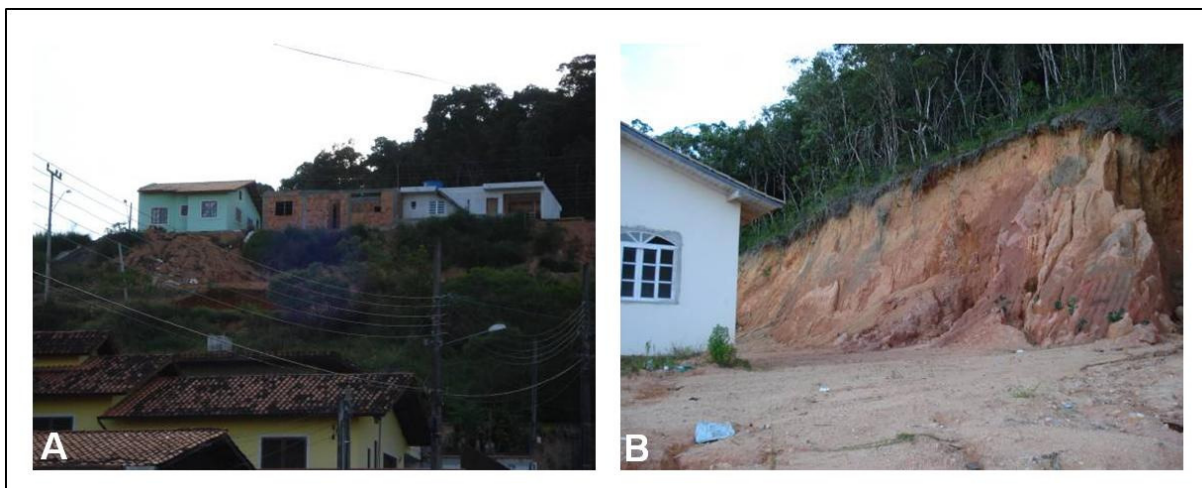
Figura 6.35: A) Residências localizadas muito próximas das paredes das encostas. B) Ponto acima da foto anterior, mostrando outra residência muito próxima de uma encosta.
