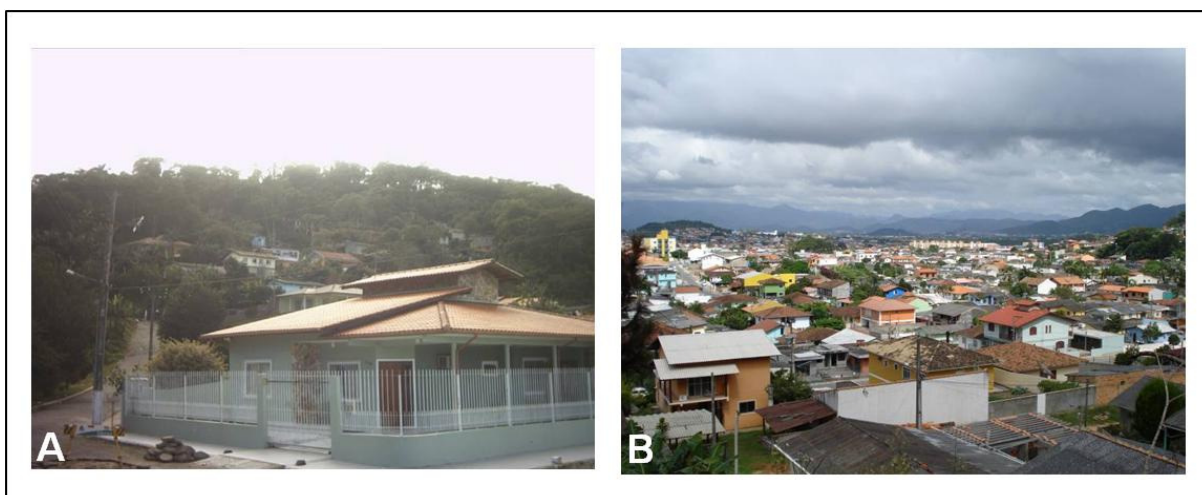
Figura 6.38: A) Ocupações inadequadas nas encostas, bairro Forquilha. B) Vista parcial da urbanização localizada na planície de inundação do rio Forquilha.
