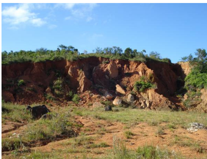
Figura 6.34: Material instável na vertente devido a sua retirada.
