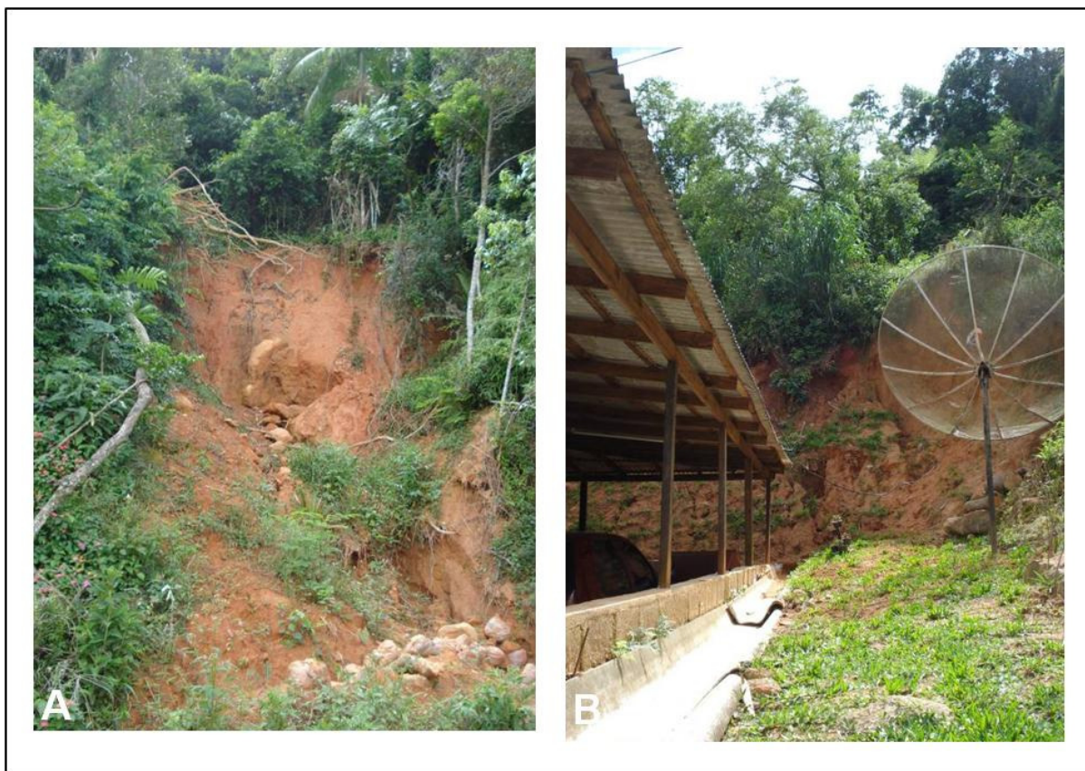
Figura 6.22: A) Escorregamento próximo ao bairro Jardim das Palmeiras. B) Ponto abaixo do local onde ocorreu o escorregamento.
