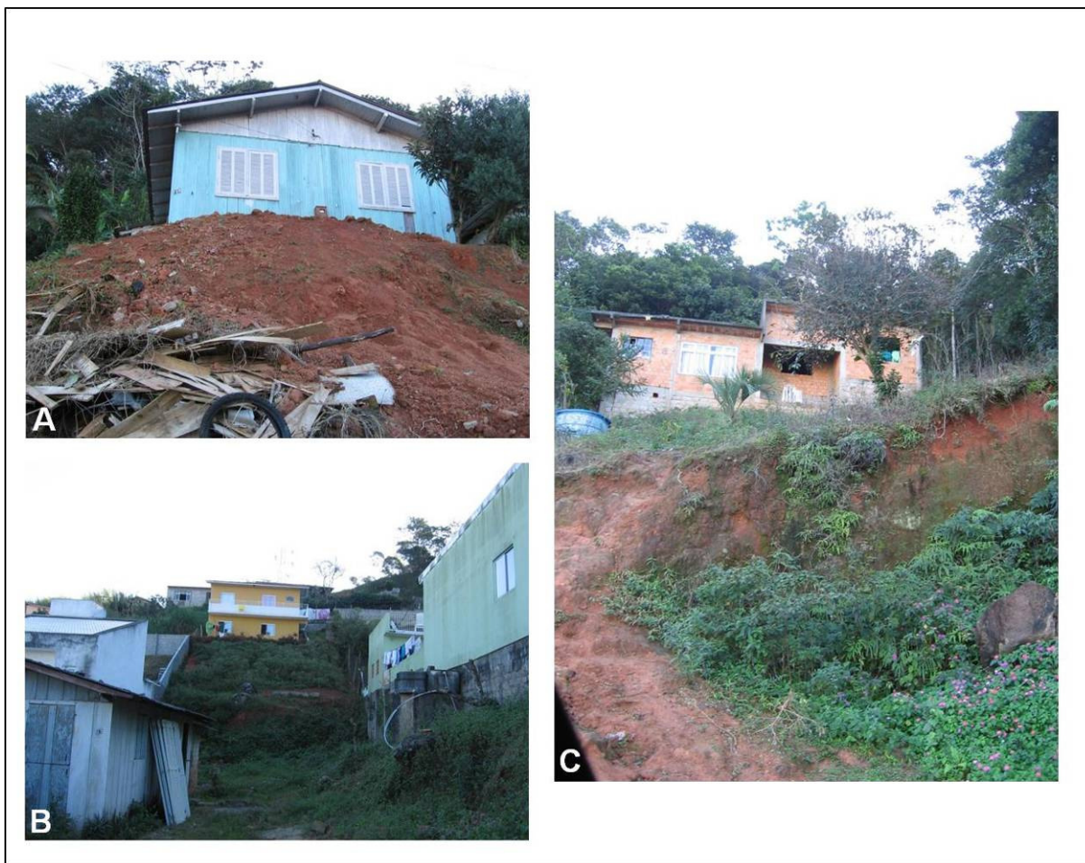
Figura 6.40: A, B e C) Detalhe das ocupações localizadas nas encostas do bairro Forquilha.
