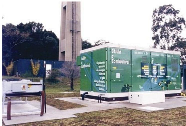
Figura 1-5 - Planta estacionária de geração de energia utilizando CaC do tipo PAFC [10].
