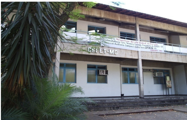
Figura 2 - Fachada leste do prédio escolar do Campus VI do CEFET MG .
