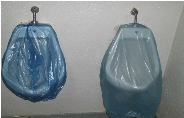
Figura 7 - Mictórios de instalação sanitária do primeiro pavimento.
