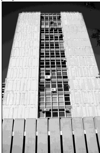
Figura 152 - Ceisa Center – Fachada para a Av. Osmar Cunha. Projeto: Liz, Cassol e Monteiro [1975] - 2007
