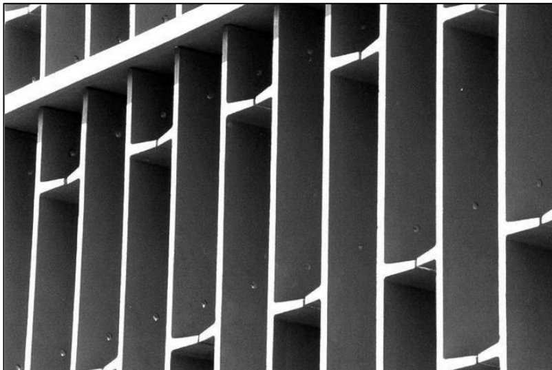
Figura 100 - Palácio Santa Catarina. Detalhe dos brises da fachada original (retirados em 2008). Projeto: Broos [1967] – 2009
