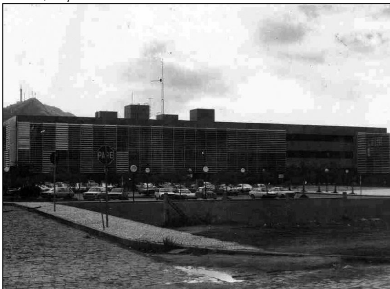
Figura 58 - Eletrosul – Vista a partir da Rua Dep. Antônio Edu Vieira [198-] Projeto: Netto [1975][Fonte: Acervo LDA UFSC, 2009]
