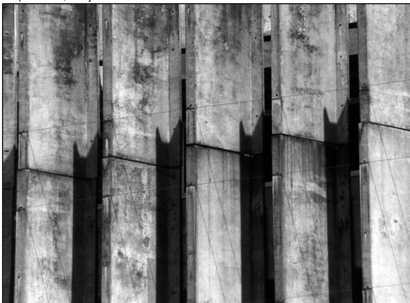
Figura 135 - Sede da CELESC - Detalhe estrutura. Projeto: Liz, Monteiro e Brena [1986] - 2003
