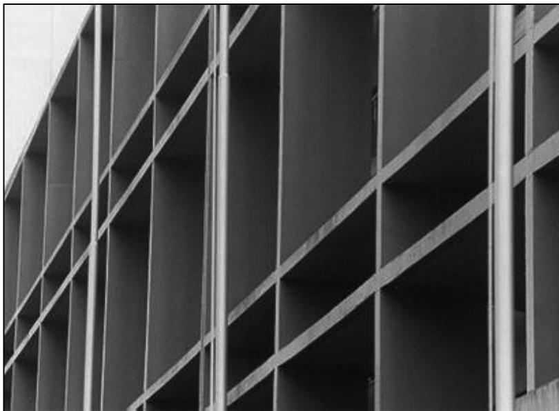
Figura 101 - Palácio Santa Catarina. Detalhe dos brises da fachada voltada para Praça Cívica Tancredo Neves. Projeto: Broos [1967] - 2005
