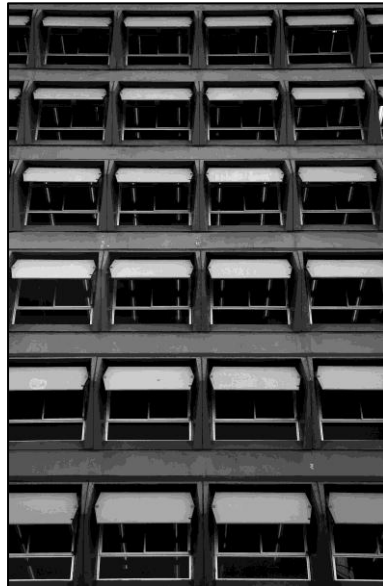
Figura 156 - Sede da Tractebel – Detalhe estrutura e brises. Projeto: Liz e Monteiro [1982] - 2007
