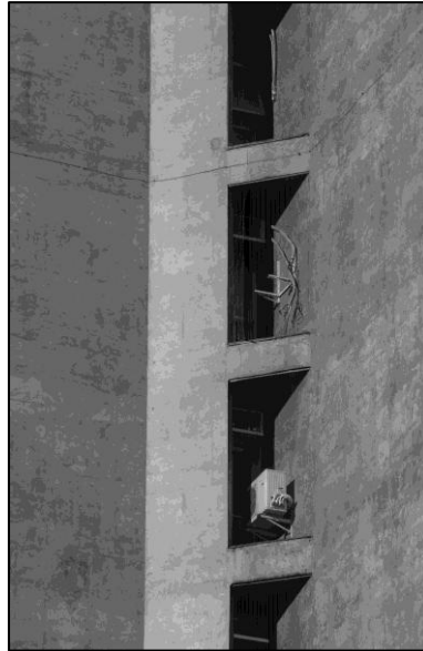
Figura 91 - Palácio da Justiça. Projeto: Saraiva, Petracco e Bussab [1968] Detalhe aberturas. 2008.
