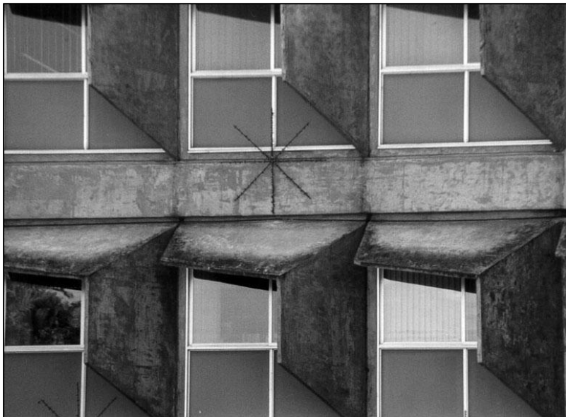
Figura 120 - Sede da TELESC – Detalhe da estrutura e brises. Projeto: Liz e Monteiro [1972] - 2003
