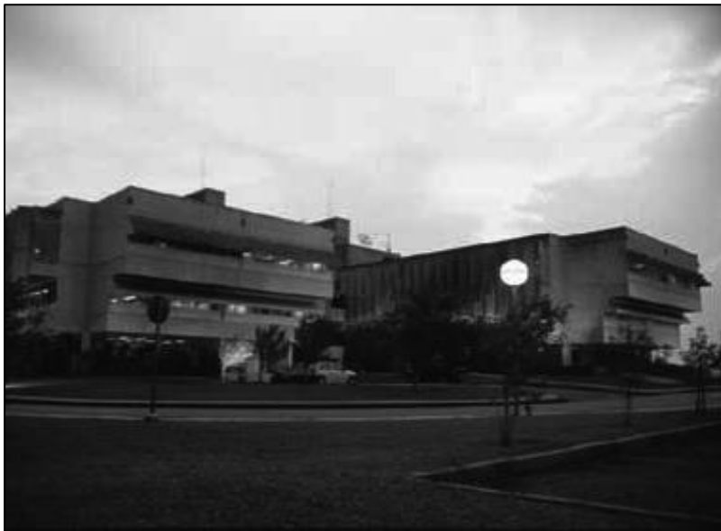
Figura 134 - Sede da CELESC - Vista a partir do jardim. Projeto: Liz, Monteiro e Brena [1986][Fonte: Tempo Editorial, 2000]
