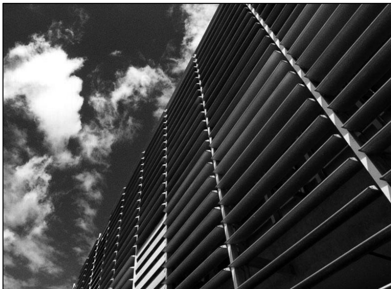
Figura 62 - Eletrosul – Detalhe brises em alumínio [2003] Projeto: Netto [1975]
