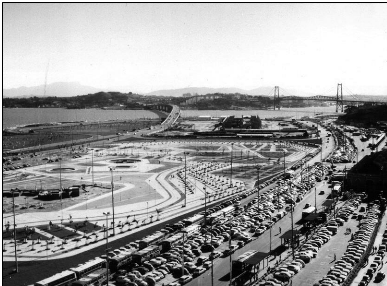
Figura 70 - Aterro da Baía Sul e obras do Terminal Rodoviário Rita Maria [1980][Fonte: Silva, 2002]
