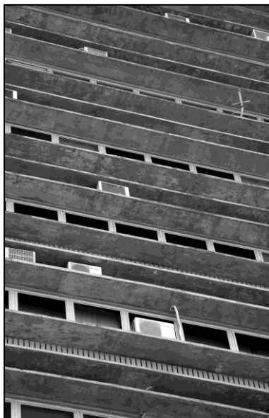
Figura 153 - Ceisa Center – Detalhe aberturas. Projeto: Liz, Cassol e Monteiro [1975] - 2007
