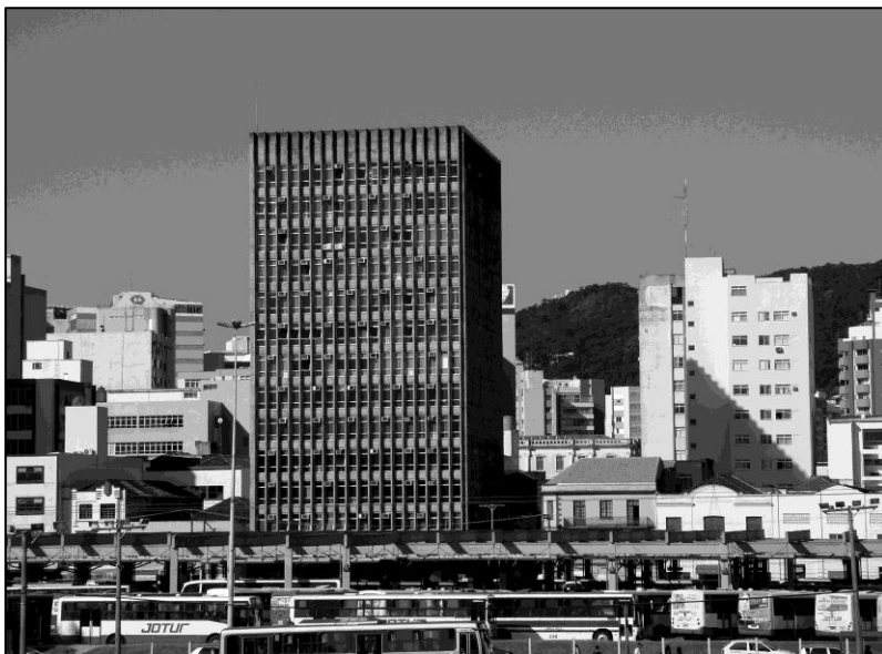
Figura 105 - Secretaria Estadual de Educação - Vista do aterro da Baía Sul. Projeto: Liz, Cassol e Monteiro [1972] - 2008
