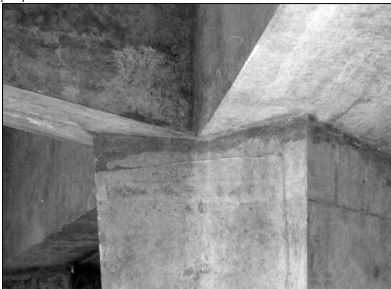
Figura 109 - Secretaria Estadual de Educação - Detalhe estrutural. Projeto: Liz, Cassol e Monteiro [1972] - 2007
