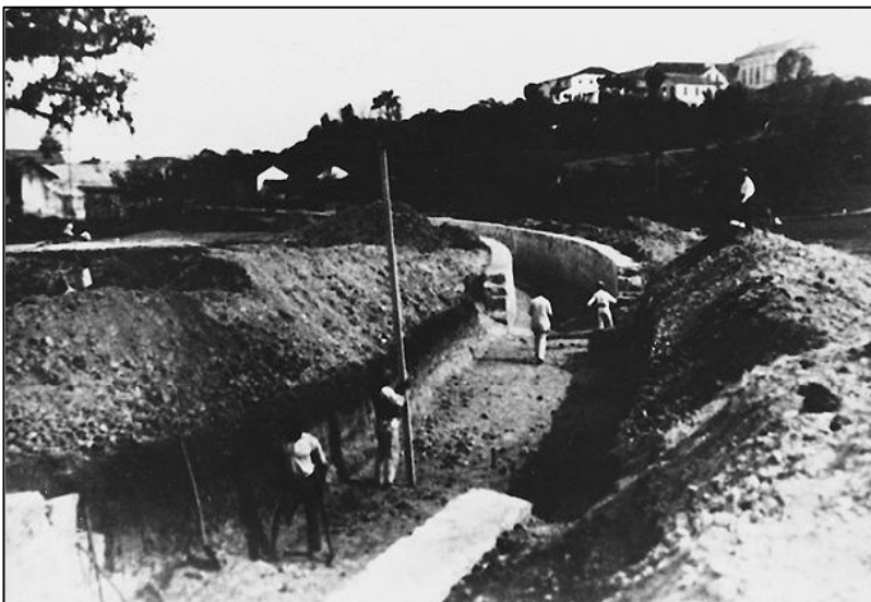
Figura 7 - Obras de canalização do Rio da Bulha [192-][Fonte: Arquivo DAEX/UFSC, 2004]
