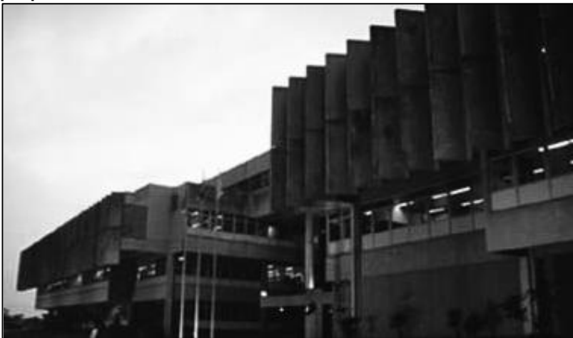
Figura 133 - Sede da CELESC - Entrada principal. Projeto: Liz, Monteiro e Brena [1986][Fonte: Tempo Editorial, 2000]
