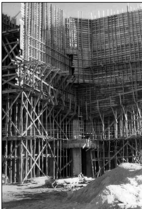
Figura 30 - Concretagem do primeiro nível do Tribunal de Justiça de Santa Catarina [196-] Projeto: Saraiva, 1968 [Fonte: Acervo Tribunal de Justiça, 2005]
