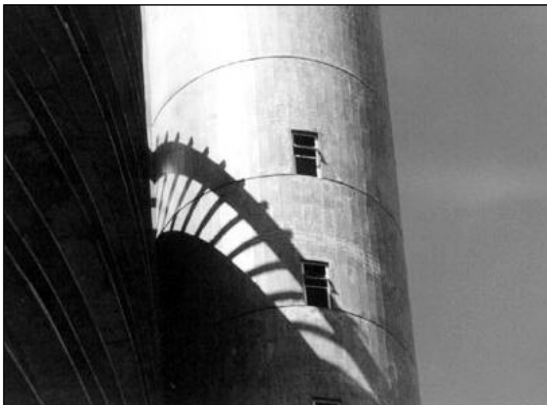
Figura 148 - Ceisa Center – Detalhe escada helicoidal. Projeto: Liz, Cassol e Monteiro [1975] - 2005
