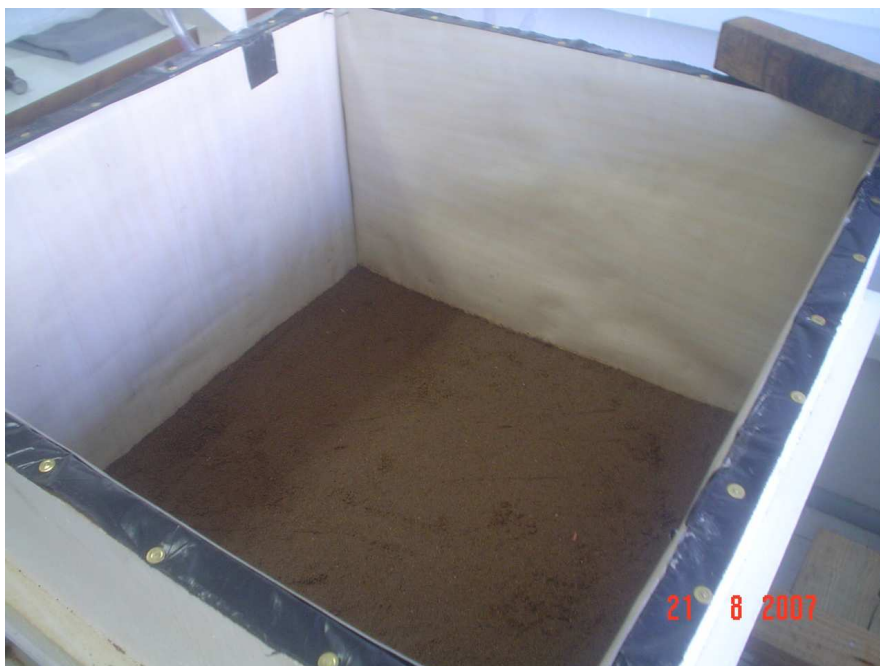
Figura 3.42 – Camada do subleito após a compactação.
