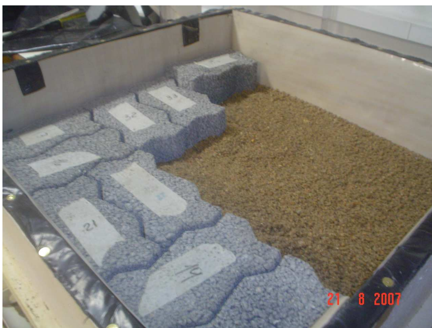
Figura 3.47 – Assentamento dos Blocos e compactação da camada de assentamento.
