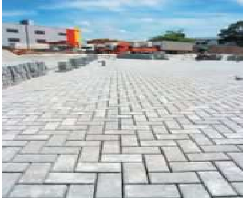
Figura 2.23 – Pavimento permeável aplicado no porto de Itajaí-SC (Revista Prisma, 2005).
