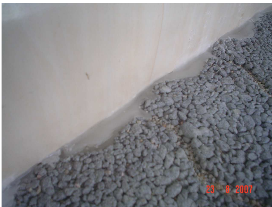
Figura 3.51 – Vedação lateral do topo da estrutura com parafina e silicone.
