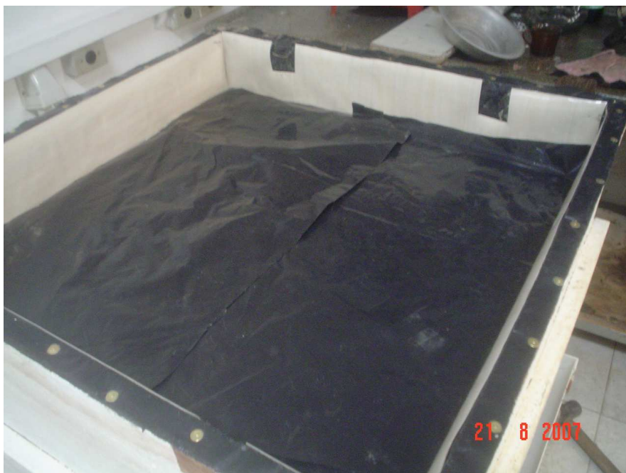
Figura 3.52 – Proteção da estrutura contra perda de umidade por evaporação.
