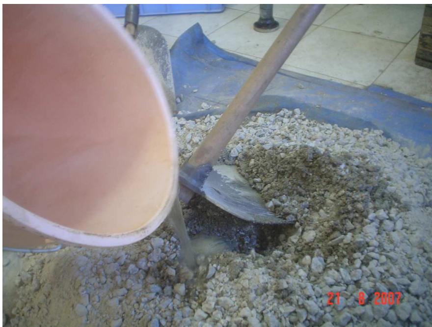
Figura 3.44 – Homogeneização da camada de Base.
