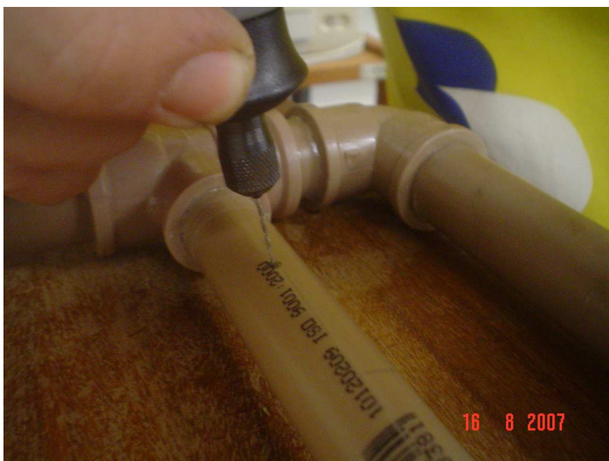
Figura 3.37 – Furação da tubulação da grelha.
