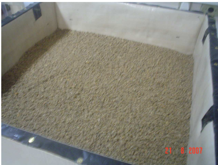
Figura 3.46 – Nivelamento da camada de assentamento.
