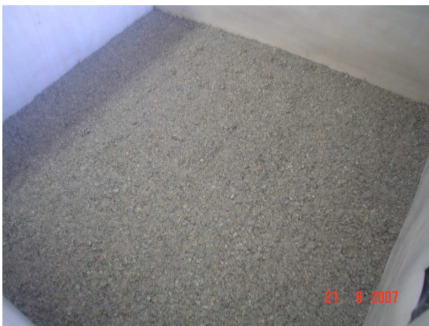
Figura 3.45 – Camada de Base após compactação.
