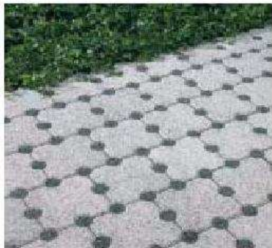
Figura 2.22 - Aberturas de drenagem (Febestral, 2005)
