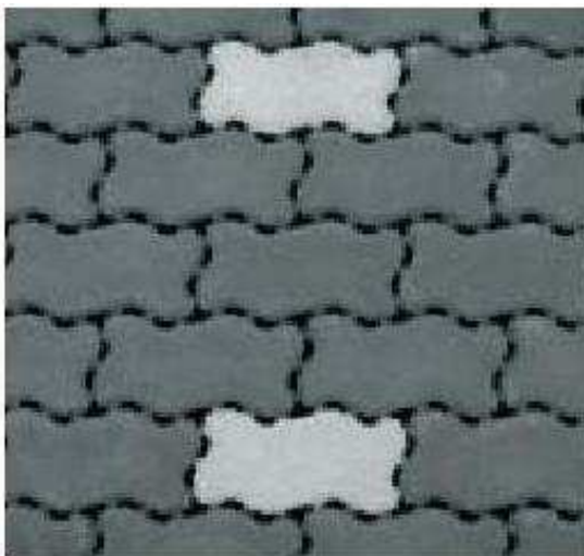
Figura 2.21 - Juntas alargadas (Febestral, 2005)
