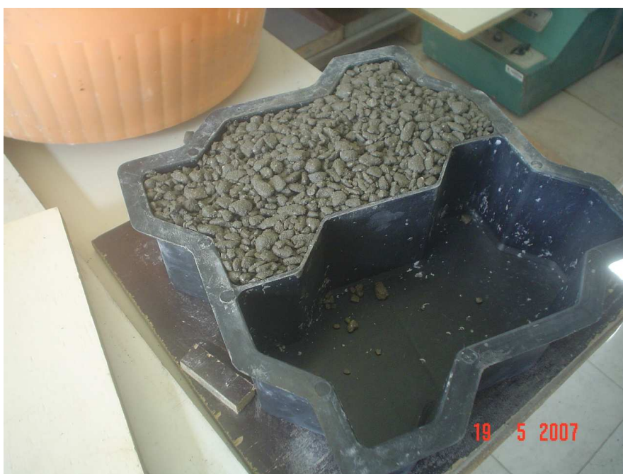
Figura 3.23 – Preenchimento da forma.
