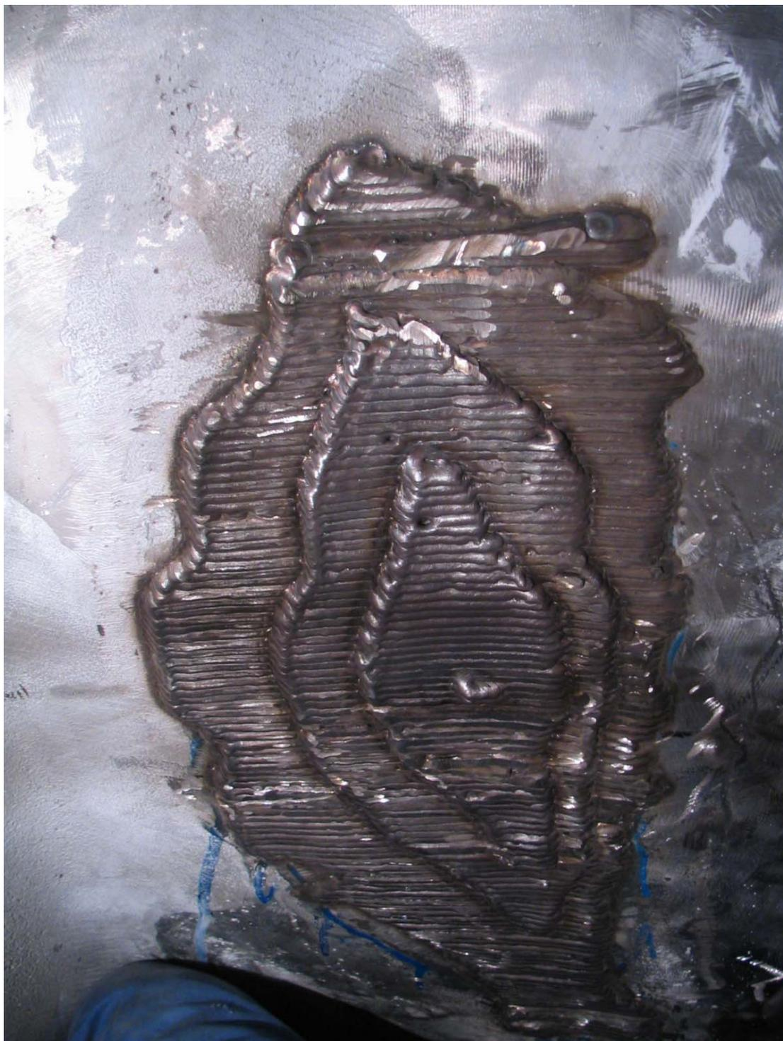
Figura 51: Resultado da Recuperação Automática com o Sistema Roboturb na Usina Hidrelétrica de **GBM**.
