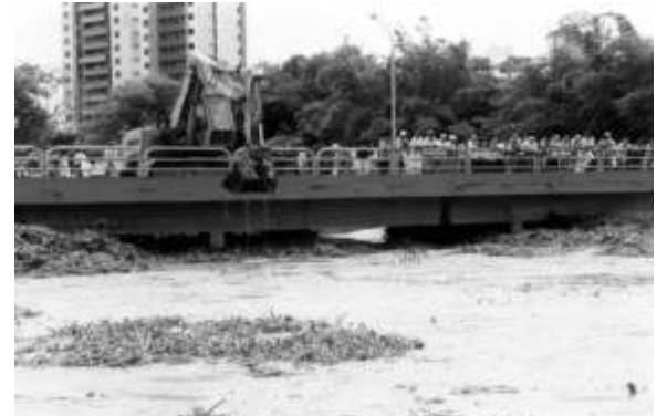
Foto 2: Remoção de macrófitas acumuladas na ponte da cidade de Itabuna (Foto: autor)
