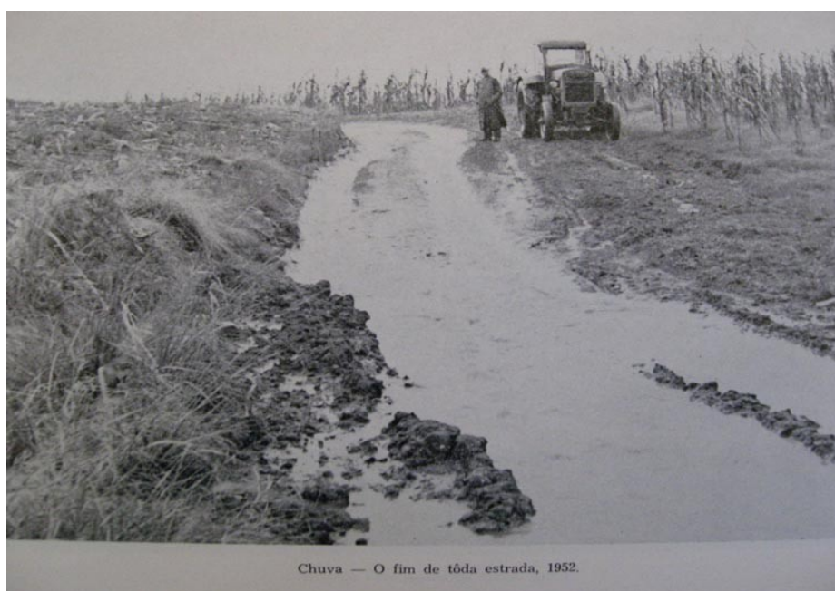
Figura nº 10: Imagem de uma estrada alagada pela chuva em Entre Rios
