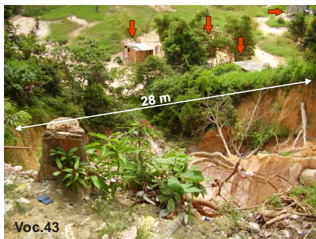
FIGURA 66 – Moradias (setas vermelhas) a jusante da voçoroca nº 43. João Paulo II. Bairro Jorge Teixeira. Zona Leste. Manaus-AM. (2006).
