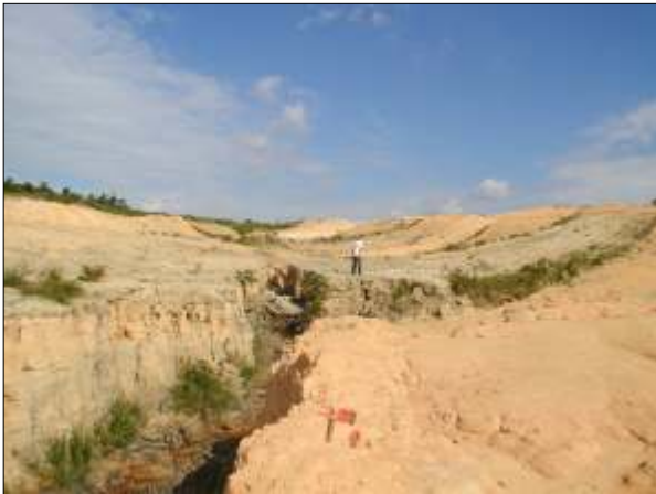
Voçoroca n. 49 e área desmatada e terraplanada para expansão do conjunto habitacional João Paulo II, Cidade Nova, Zona Norte, Manaus (2006).
