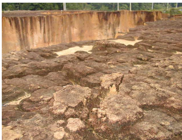
FIGURA 34 – Superfície encrostada na borda da Voçoroca nº. 11. Distrito Industrial – Manaus (AM). (2003).
