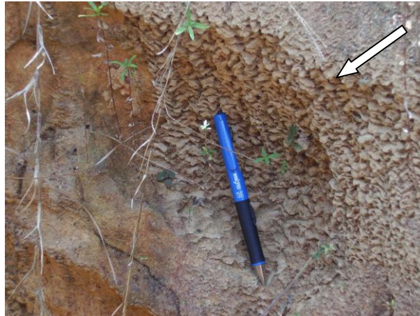
FIGURA 21 – Escamamentos. Parede da Voçoroca nº 9. Área do 1º BIS (Amv). Bairro São Jorge. Zona Oeste. Manaus-AM. (2006)
