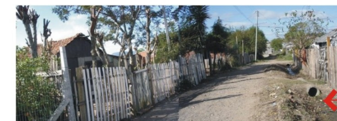
Esgoto à céu aberto
