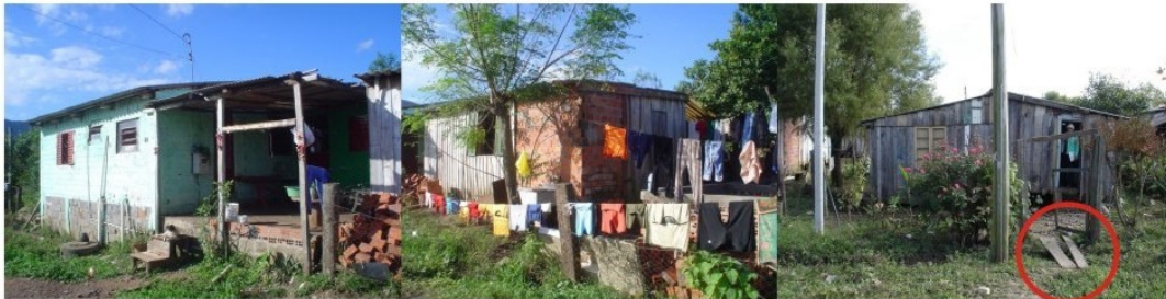
Casas sem fechamento entre o lote e a rua.
