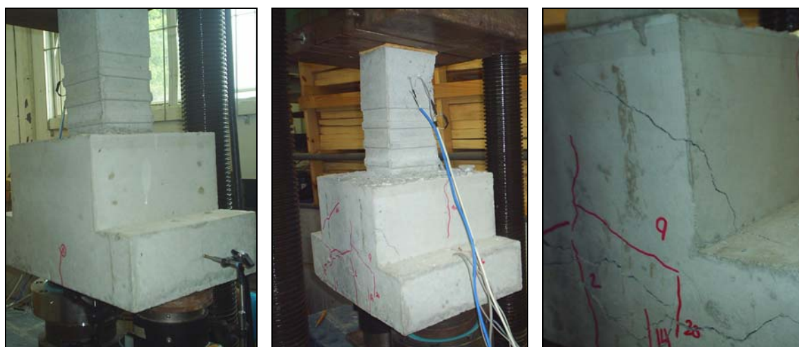
Figura 4.8 – Fissuras apresentadas no Modelo C3.
