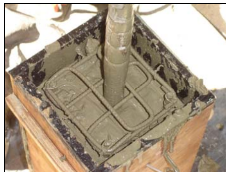
Concretagem do pilar.
