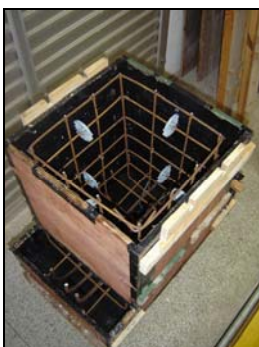
Fôrma pronta para iniciar a concretagem.
