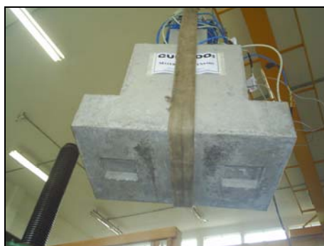
Içamento e colocação do bloco sobre as estacas.
