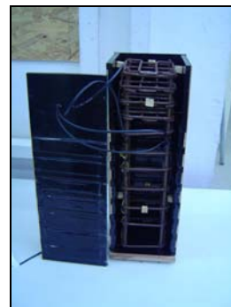
Fôrma do pilar pronta para ser concretada.
