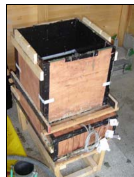
Fechamento da fôrma (abas laterais).
