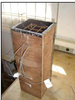
Pilar pronto para concretagem.
