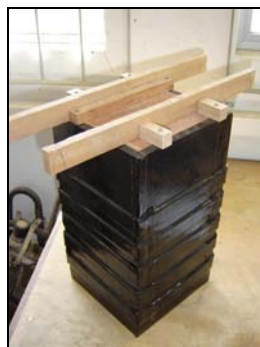
Parte interna da fôrma do cálice.
