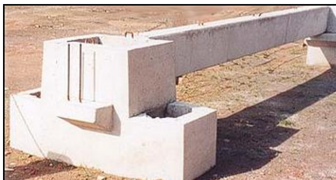
Figura 1.1 – Bloco de fundação pré-fabricado sobre duas estacas a espera do pilar.
