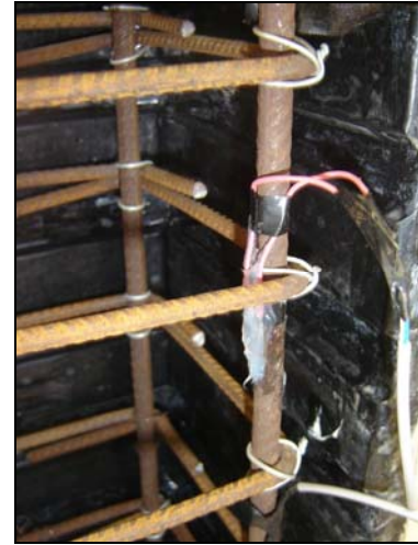
Figura 3.22 - Extensômetros instalados na armadura do pilar.
