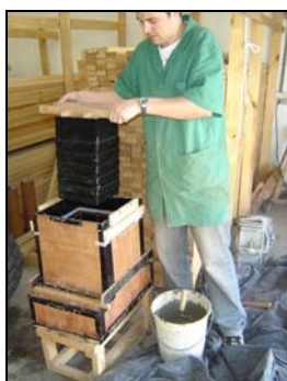
Colocação da fôrma da parte interna do cálice.
