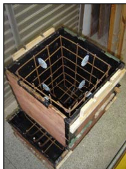
Fôrma do bloco pronta para iniciar a concretagem.
