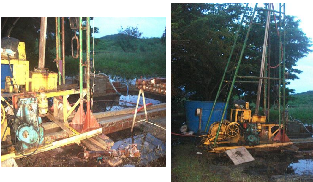
Figura 14: Construção de poço artesiano no Hotel 6
