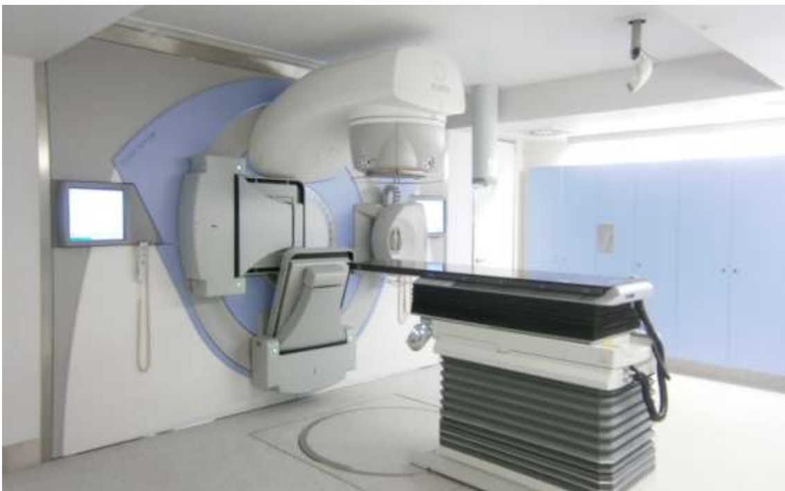
Figura 4.1: Acelerador Linear Elekta Synergy instalado no serviço de radioterapia da Fundação Champalimaud (Lisboa).
