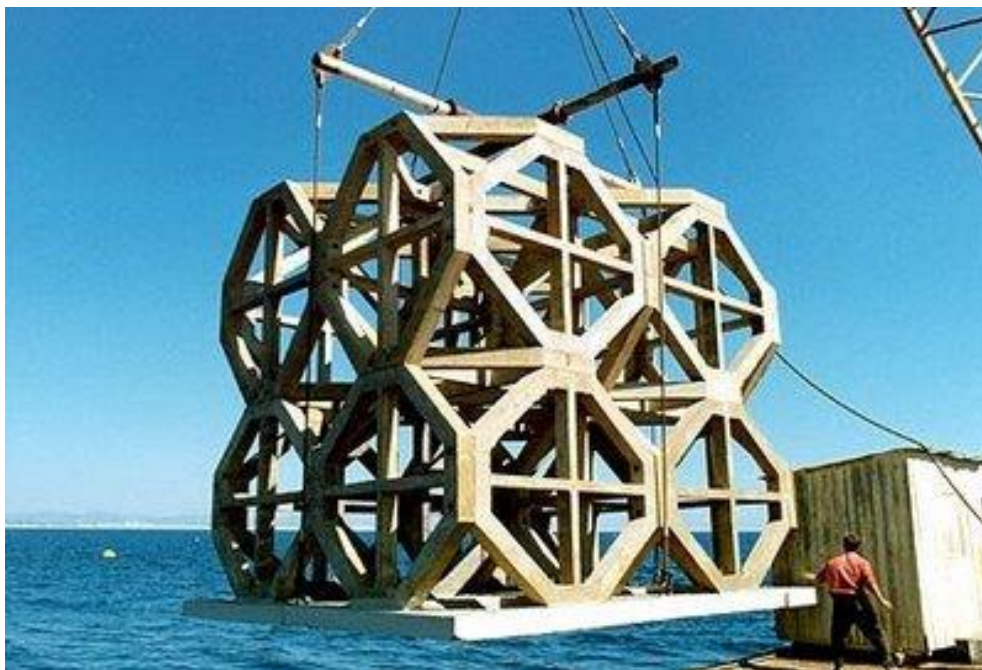
Figura 1.2 – Módulo de um recife de exploração colocado na costa do Algarve (MPT Algarve, 2009)
