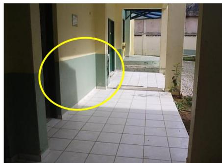
Figura 52. Diferenciação cromática entre plano horizontal e vertical em outros ambientes da escola.
