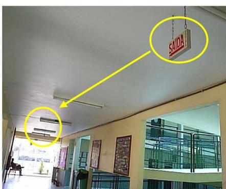
Figura 61. Seqüência de placas indicando a saída no caso de emergência (rota principal da escola no térreo).
