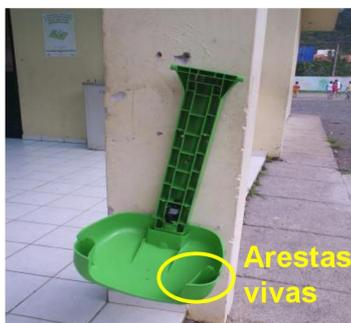
Figura 77. Elemento quebrado no ambiente do pátio interno.
