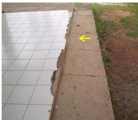
Figura 65. Irregularidades do piso no perímetro do pátio interno.
