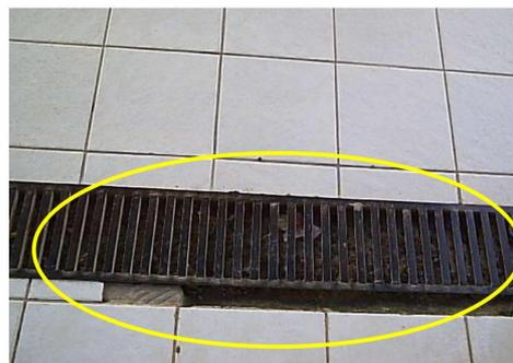
Figura 73. Detalhe de buraco junto à grelha.
