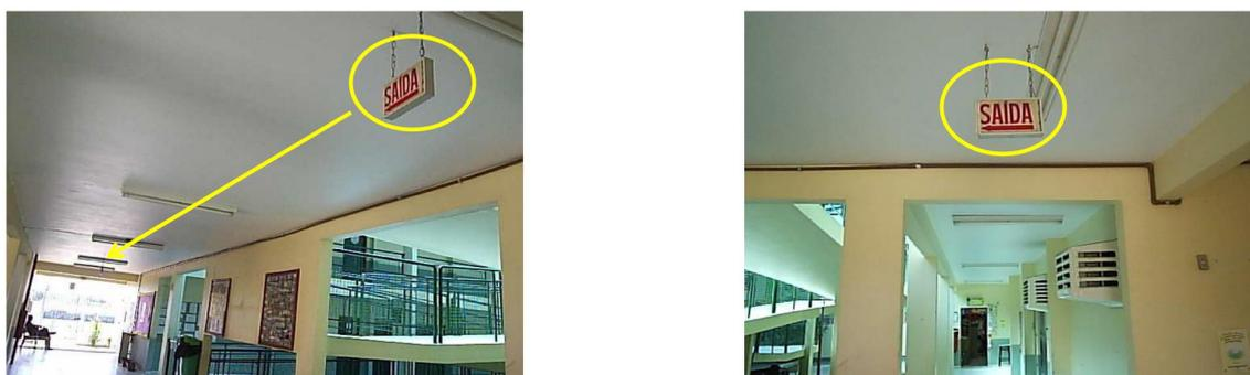
Figura 64. Dispositivos de sinalização indicando a saída da escola em caso de emergência (rota principal no térreo).
