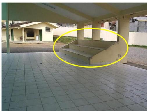
Figura 60. Diferenciação cromática e formal da arquibancada com o entorno.
