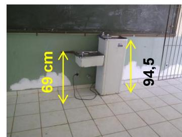
Figura 94. Altura do bebedouro disponível no acesso ao pátio interno.
