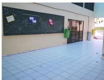
Figura 84. Piso cerâmico utilizado no pátio interno.
