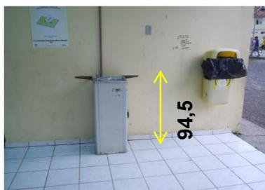
Figura 93. Altura do bebedouro disponível no pátio interno.
