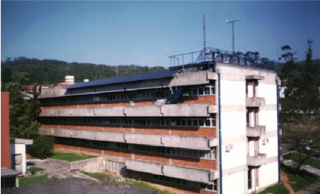
**Figura 17 :** Sistema solar fotovoltaico de 2.078 Wp instalado na UFSC em Florianópolis. A superfície de aproximadamente 40 m<sup>2</sup>, apresenta uma inclinação de 27° e está orientada para o norte geográfico.
