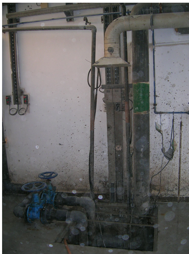
Figura A3.4 - Extracção das escorrências da centrifugadora.
