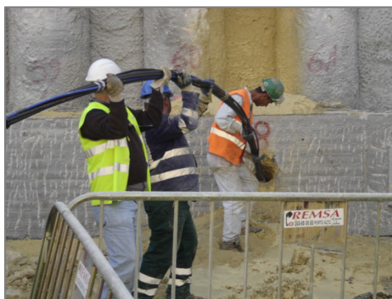
b) Colocação da armadura da ancoragem no furo.
