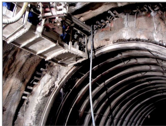
Figura 4.12 – Realização de enfilagens na reabilitação do túnel do Rossio ( www.refer.pt ).
