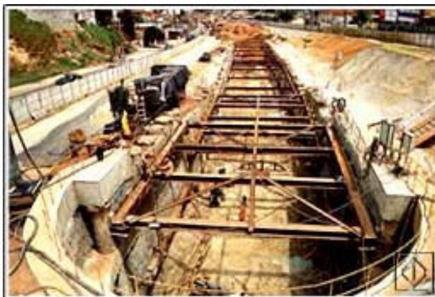
Figura 4.3 – Emboquilhamento do túnel Tucuruvi em “Cut and Cover” (www.metro.sp.gov.br).
