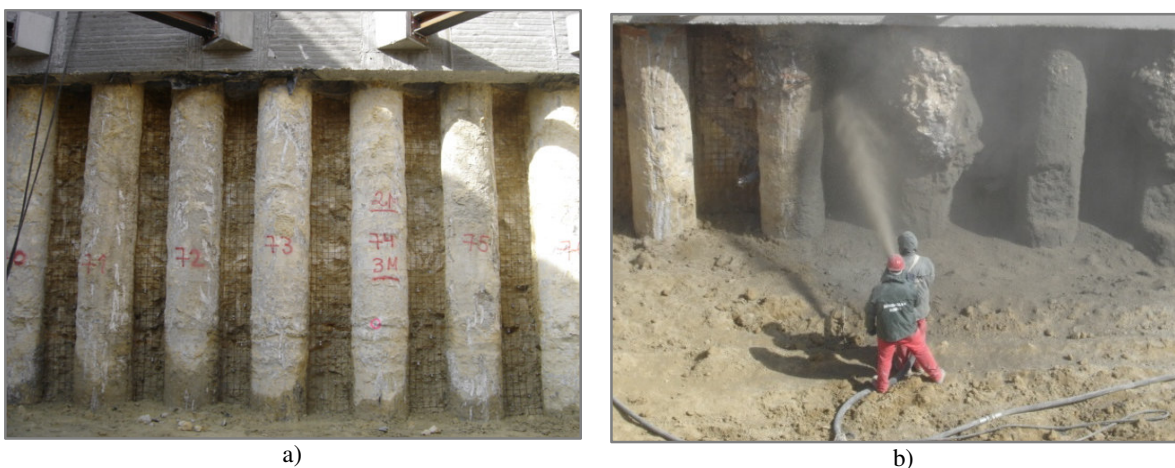
Figura 7.8 – Execução do revestimento primário: a) Colocação de malhasol; b) Betão projectado.
