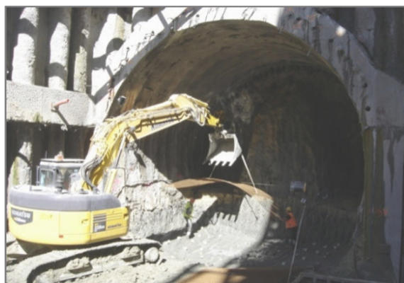
Figura 7.39 – Colocação da rede electrossoldada para realização do arco invertido.
