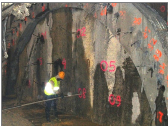
Figura 7.35 – Colocação de um dos perfis de fibra de vidro (fotografia cortesia Eng.º André Carmo).
