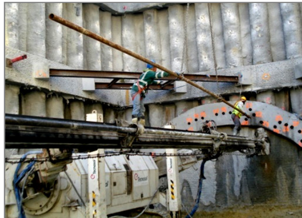
Figura 7.34 – Colocação do tubo metálico para a realização das enfilagens (fotografia cortesia Eng.º André Carmo).
