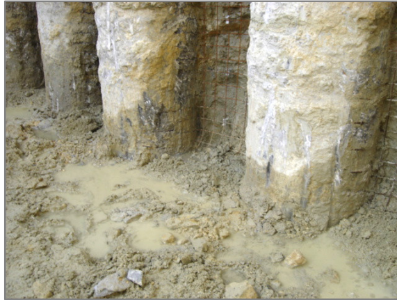
Figura 7.5 – Primeiros indícios da presença de água na escavação.
