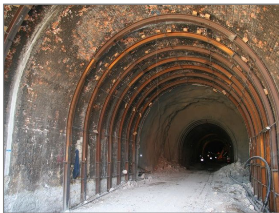
Figura 4.13 – Cambotas metálicas no túnel do Rossio (www.refer.pt).
