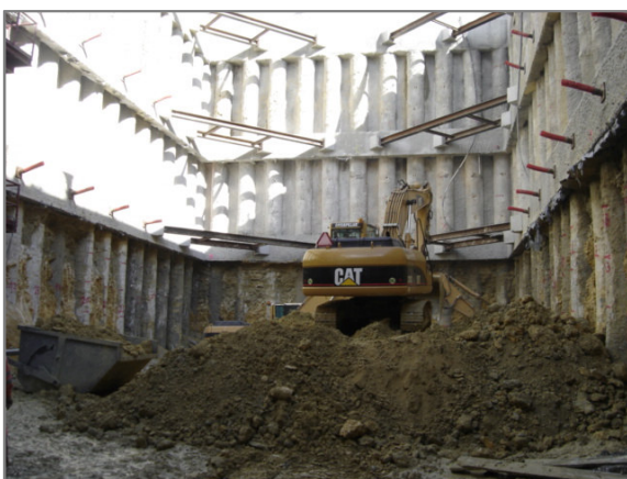
c) 3º Nível de escavação.
