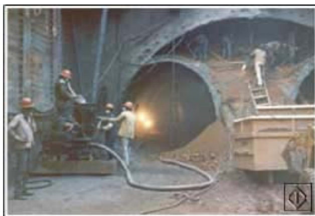
Figura 4.1 – Execução de um túnel em Guaianazes em NATM ( www.metro.sp.gov.br ).
