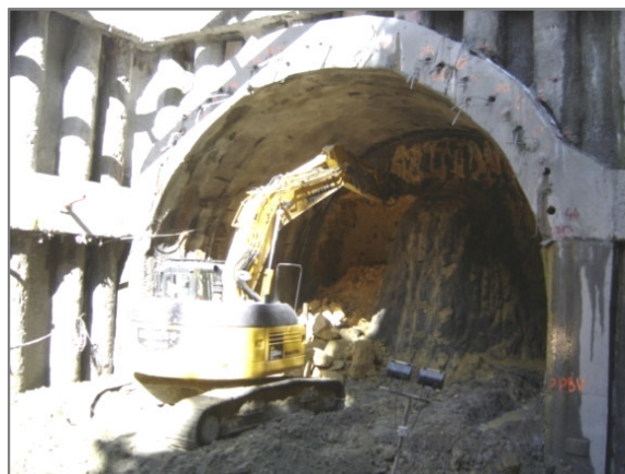
Figura 7.38 – Avanço da escavação.
