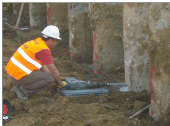
b) Realização do furo transversal na estaca para introdução do macaco hidráulico.
