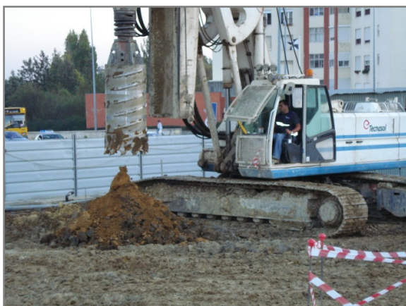
a) Furação do terreno.
