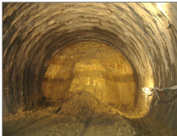
Figura 7.31 – Aspecto da frente de escavação do túnel.
