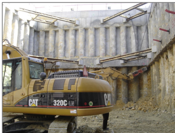
b) 2º Nível de escavação.
