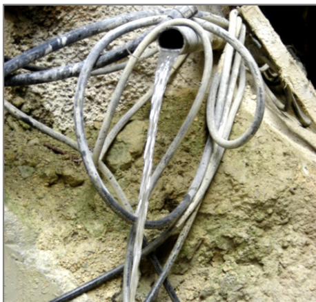
Figura 7.30 – Saída de água num dos drenos.
