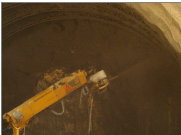
Figura 7.25 – Projecção de betão nas cambotas.
