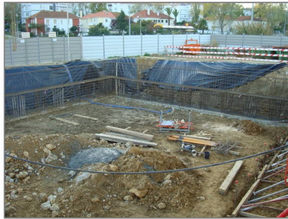
d) Execução da viga de encabeçamento.
