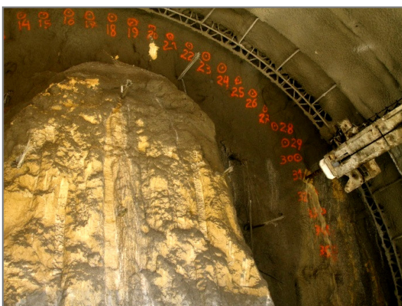
Figura 7.27 – Realização de enfilagens na abóbada.
