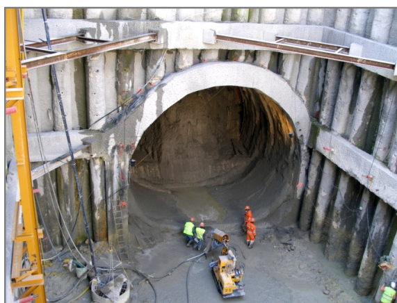
Figura 7.29 – Realização do “arco invertido”.
