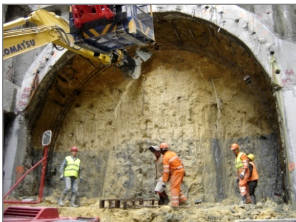
Figura 7.37 – Colocação da 1ª cambota.
