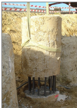
c) Remoção da cabeça da estaca.
