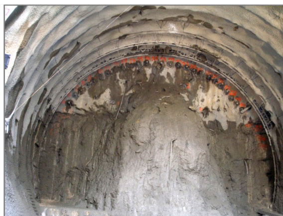
Figura 7.28 – Aspecto do tratamento da abóbada com enfilagens.
