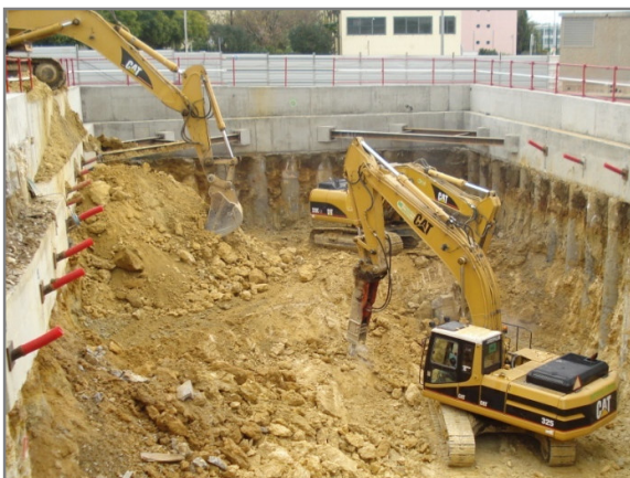
a) 1º Nível de escavação.
