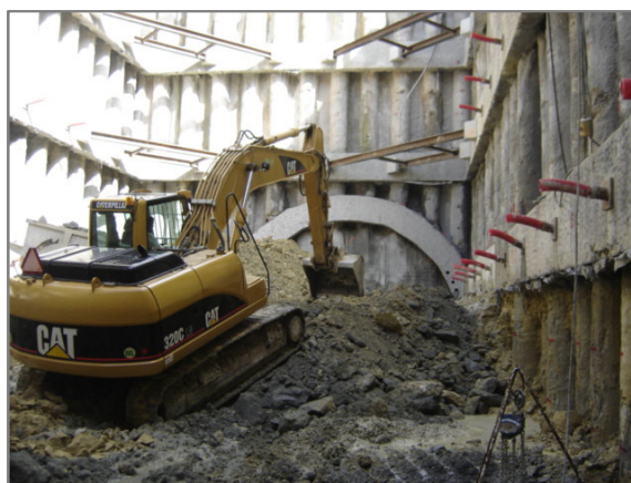
d) 4º Nível de escavação.
