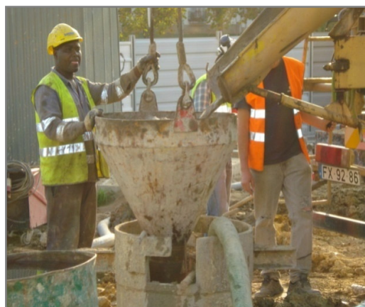
c) Betonagem da estaca.
