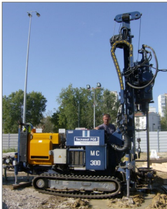
Figura 6.9 – Realização da sondagem S14A no PV-192 (fotografia: cortesia Dr. António Gaspar).
