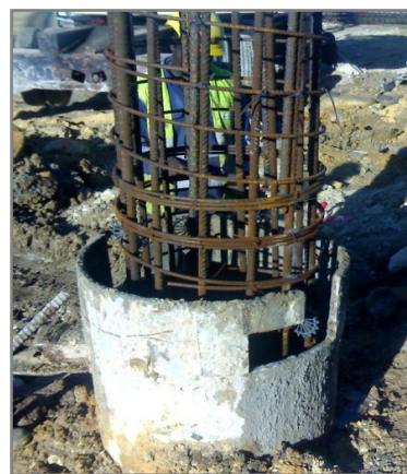
b) Colocação da armadura.
