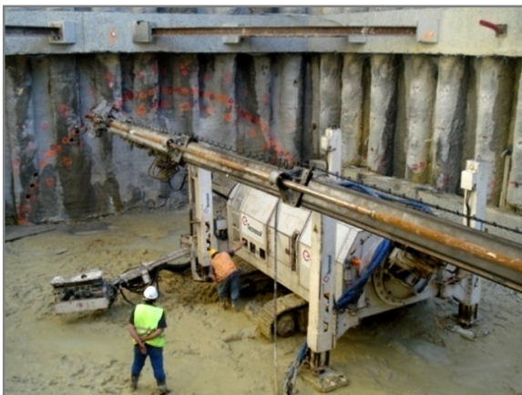
Figura 7.21 – Execução de coluna de Jet grouting (cortesia Eng.º André Carmo).
