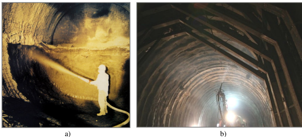
Figura 4.9 – Aplicação de betão projectado: a) na extensão da linha de metropolitano Jubilee em Londres (Kirkland et al, 1996); b) no túnel do Rossio ( www.refer.pt ).
