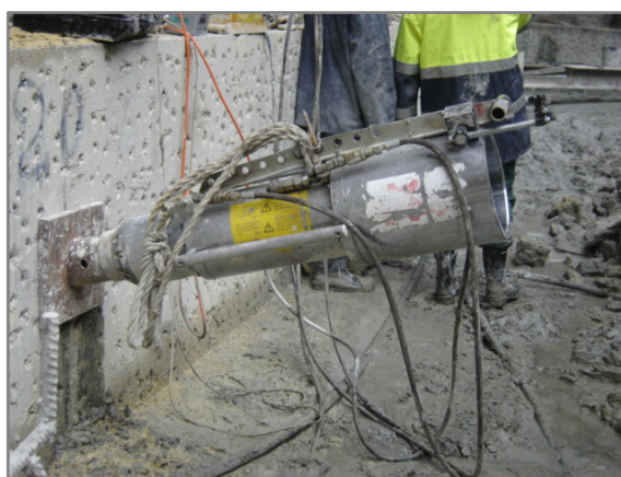
d) Tracionamento dos cabos.
