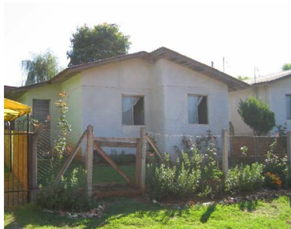
Figura 4.30: Fachada de UH em NHNE.
