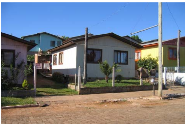
Figura 4.21: Fachada de UH em NHMB.
