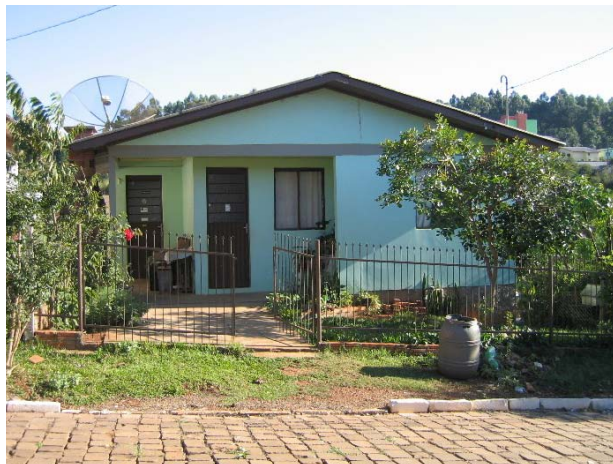
Figura 4.29: Fachada de UH em NHNE.
