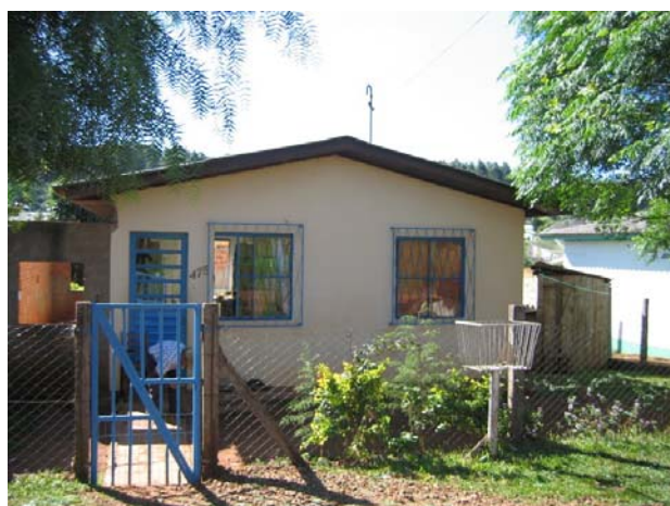
Figura 4.266: Fachada de UH em NHSL.
