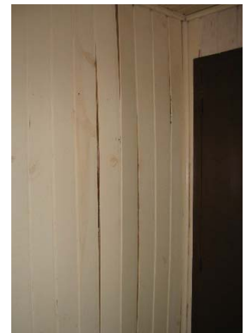
Figura 5.5 – Parede divisória entre quartos - UH MB H1-2.
