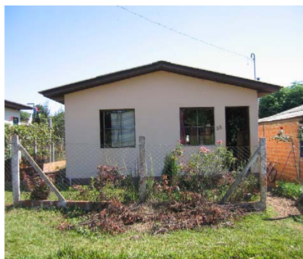
Figura 4.255: Fachada de UH em NHSL.
