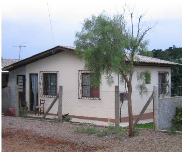
Figura 4.24: Fachada de UH em NHSL.
