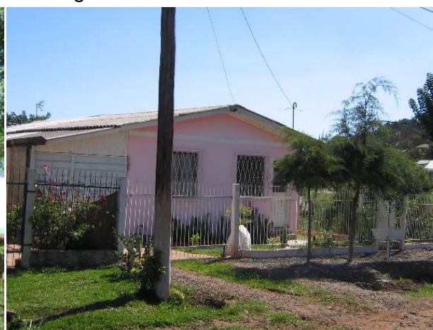
Figura 4.277: Fachada de UH em NHSL.
