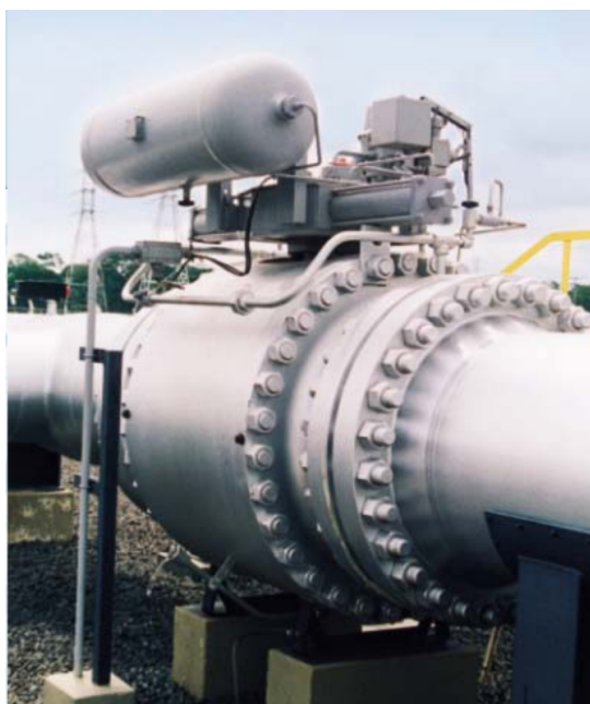
Figura 1.4: Válvula de bloqueio de trecho. Elas normalmente são enterradas (cortesia da empresa-alvo).
