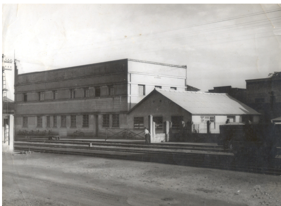
Figura 69 - Sede administrativa da RFFSA. Fonte: Arquivo Histórico Municipal.
