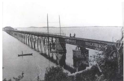
Figura 39 – Construção da ponte Lagoa Mirim. Fonte: Arquivo Histórico Municipal.
