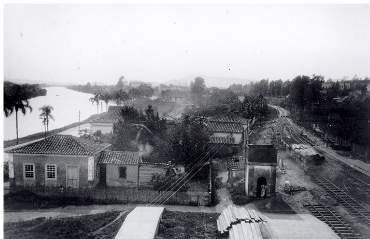
Figura 60 - Vista do leito da ferrovia, à direita, - 1933. Fonte: Arquivo Histórico Municipal.
