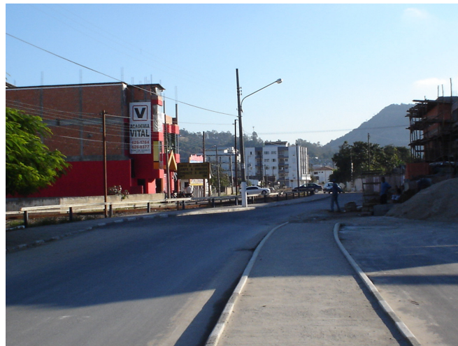
Figura 122 – Local de obstrução da Avenida. Fonte: Acervo Rodrigo Althoff Medeiros.
