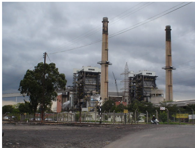
Figura 76 - Eletrosul Centrais Elétricas S.A - Subestação Jorge Lacerda B. Fonte: Acervo Rodrigo Althoff Medeiros.
