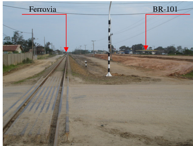
Figura 126 – Obras de duplicação da BR-101 ao lado do leito da ferrovia. Fonte: Acervo Rodrigo Althoff Medeiros.
