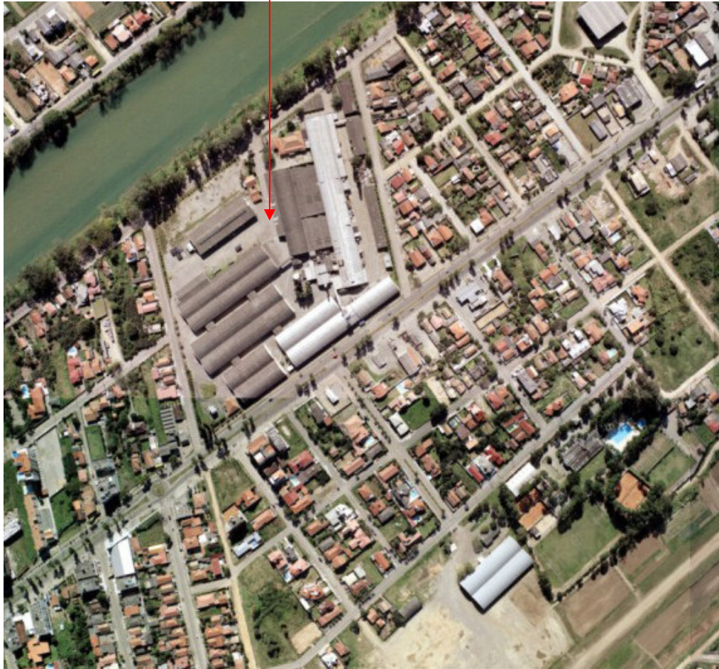
Figura 99 – Bairro Vila Moema com os galpões do Shopping center . Fonte: Acervo Rodrigo Althoff Medeiros.
