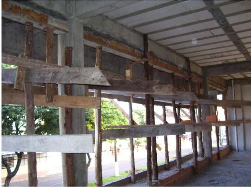
FOTO 4: Formas e escoramentos da viga V223 e abaixo, mureta de alvenaria.
