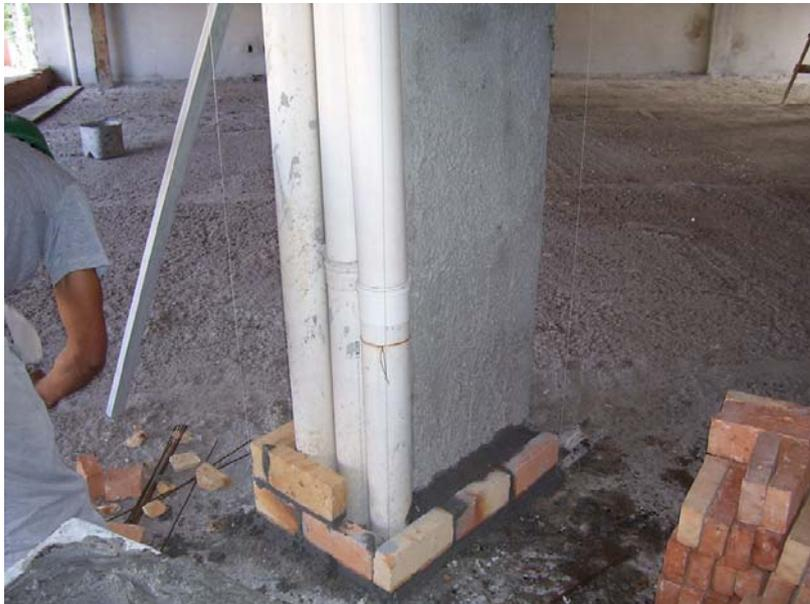
FOTO 7: Detalhe da alvenaria sendo executada com o auxílio das linhas-guia apuradas para eliminar a atividade de colocar o prumo a cada fiada
