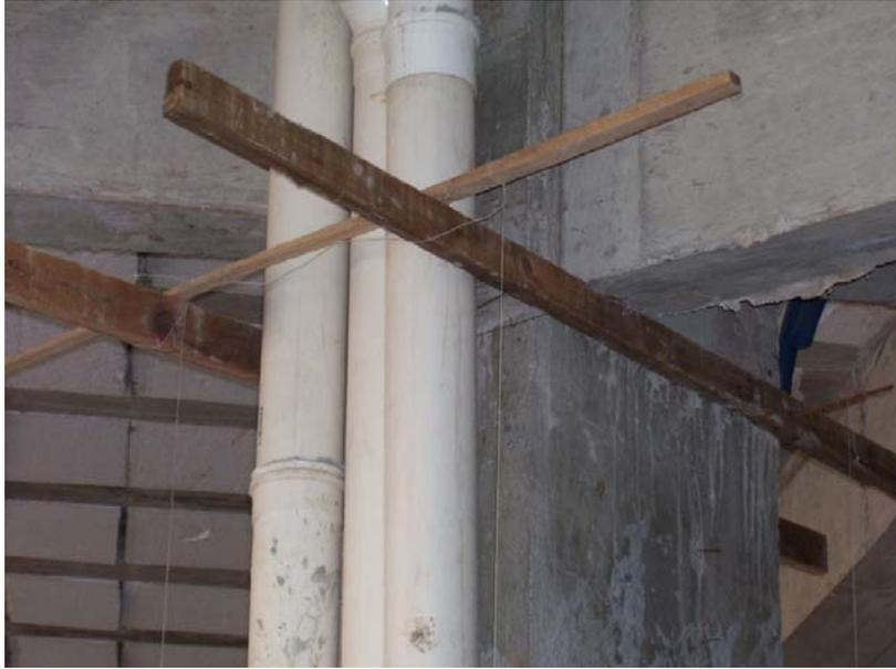
FOTO 6: Detalhe de equipamento improvisado utilizado para eliminar a tarefa de apurar os cantos da parede em cada fiada
