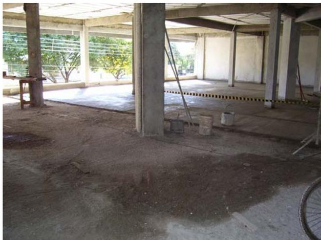
FOTO 22: Contraste da célula pronta e área sem acabamento
