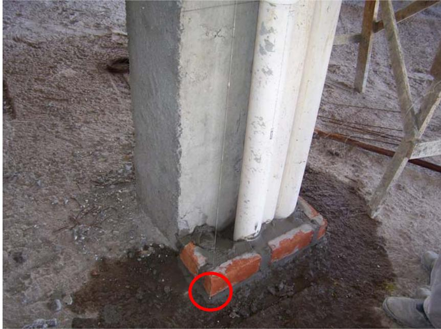
FOTO 8: Detalhe da fixação das linhas-guia na laje com prego de aço.
