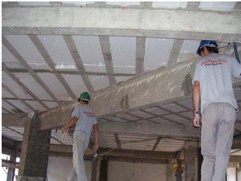
FOTO 14: Profissional 1 taqueando a viga com auxílio do servente 2
