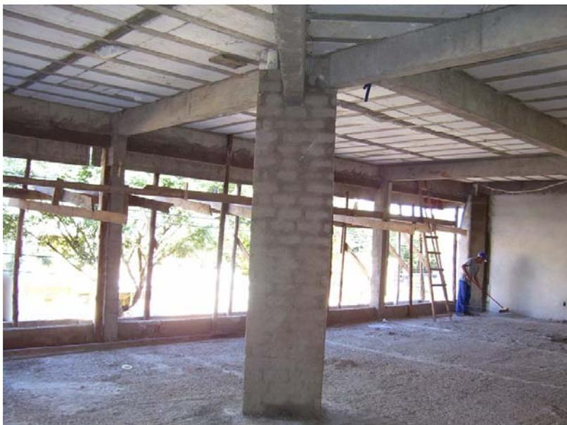
FOTO 9: Detalhe da alvenaria de tijolos maciços pronta e chapiscada, serviço executado no primeiro dia.
