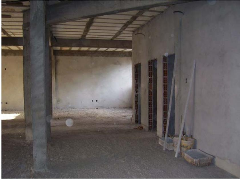
FOTO 2: Vista lateral direita da célula 1, vendo-se à esquerda os pilares P29 e P28 e à direita os vãos das portas dos banheiros
