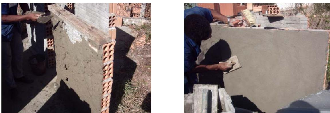
Ilustração 4.8 – Aplicação e acabamento das argamassas de revestimento
