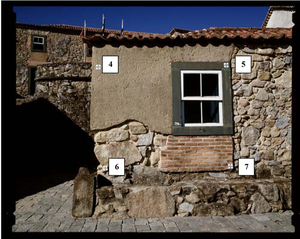
Fig 59 - Foto 59 paralelamente ao Quartel da Tropa a uma distância de 8m, com marcas fiduciais e número de seus pontos de controle.
