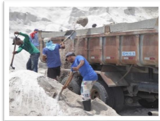
Carregando caminhão de areia com pá, Região Metropolitana do Recife
