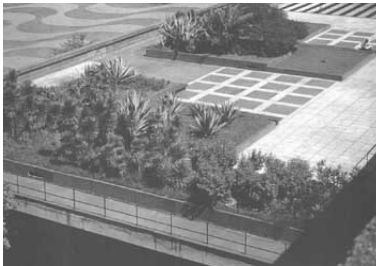
Figura 30 - Laje Jardim do Museu de Arte Moderna, Rio de Janeiro. Fonte: Siqueira, 2001.
