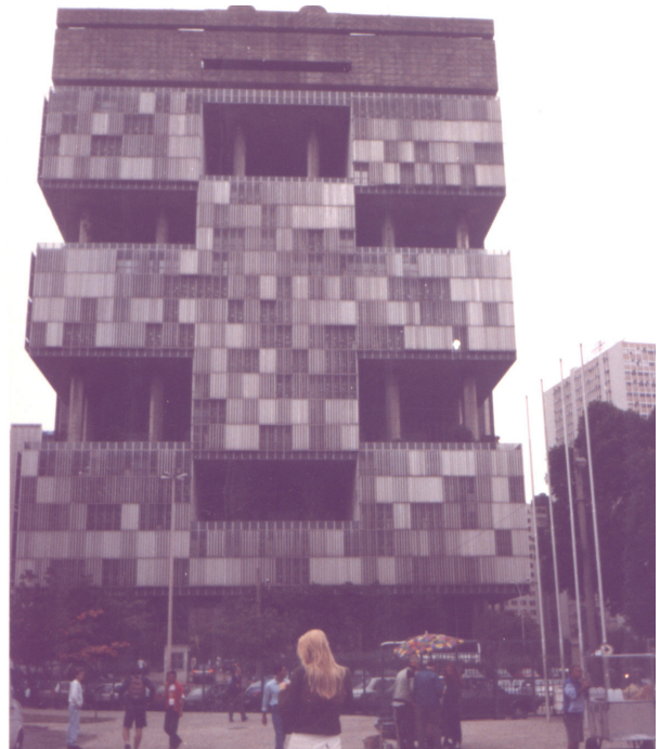
Figura 4 - Lajes Jardim do Edifício da Petrobras, Rio de Janeiro. Fonte: Monteiro, 1997.
