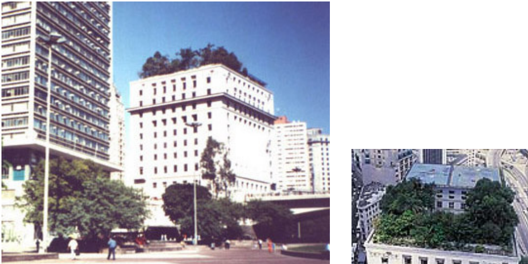
Figura 44a e 44b- Edifício Conde Matarazzo, Centro de São Paulo.
