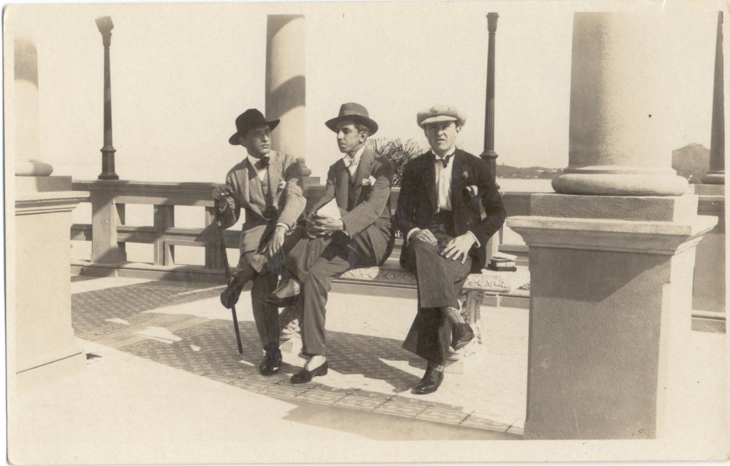
Fotografia 15 Belvedere da Ponte Hercílio Luz
