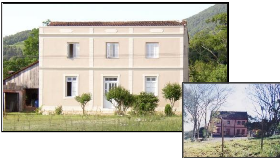
FIGURA 06: CASAS EM ESTILO COLONIAL ITALIANO
