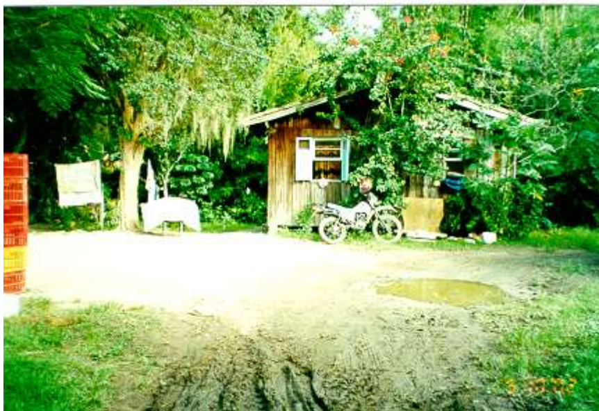
Foto 12: Fachada da casa – Emerson
