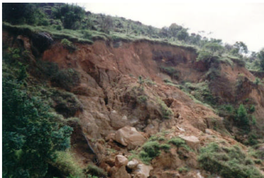
Figura 17: Região de Saco dos Limões – Observar a ocorrência de movimentos de massa e deslocamento de blocos
