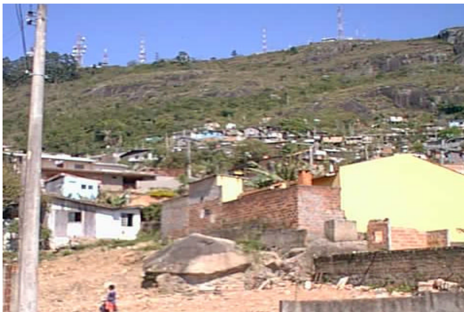
Figura 13: Vista do o morro na região da Trindade Norte - Apesar de ser uma área classificada como propícia, apresenta uma expansão urbana desordenada atingindo o morro na região da Trindade Norte. Observar na parte superior e em primeiro plano a ausência de estrutura dos lotes, mostrando a ausência de planejamento e qualidade ambiental urbana.
