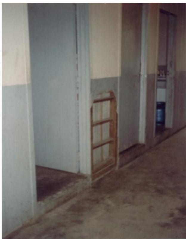
FOTO 10: DETERIORAÇÃO DO PRÉDIO, CONSEQÜÊNCIA DA BAIXA QUALIDADE DO MATERIAL UTILIZADO PARA A SUA CONSTRUÇÃO.
