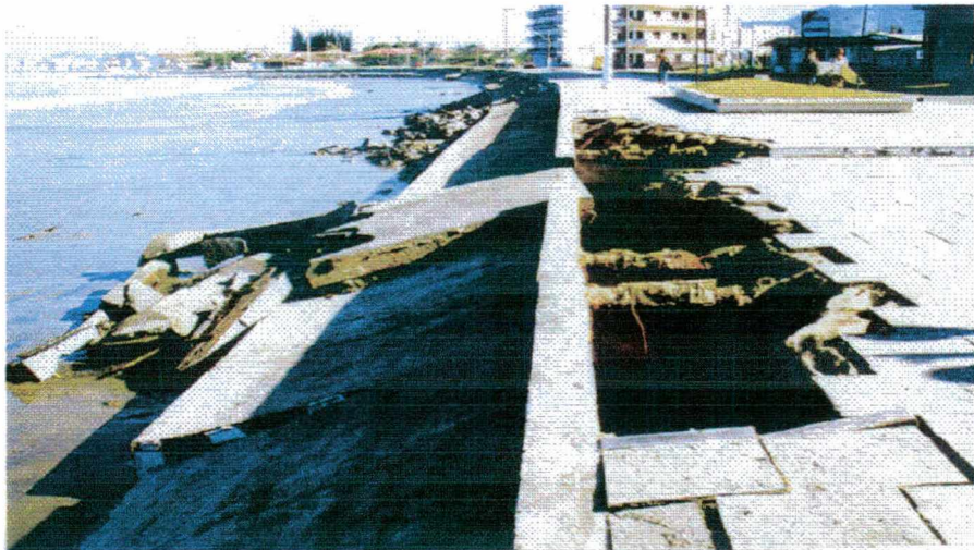
Figura 17 Fotografia orientada para sul mostrando uma visão sobre os efeitos destrutivos da praia de Gravatá após um evento de alta energia (tempestade) sobre o calçadão, 1997 (Foto: P.M.N.)
