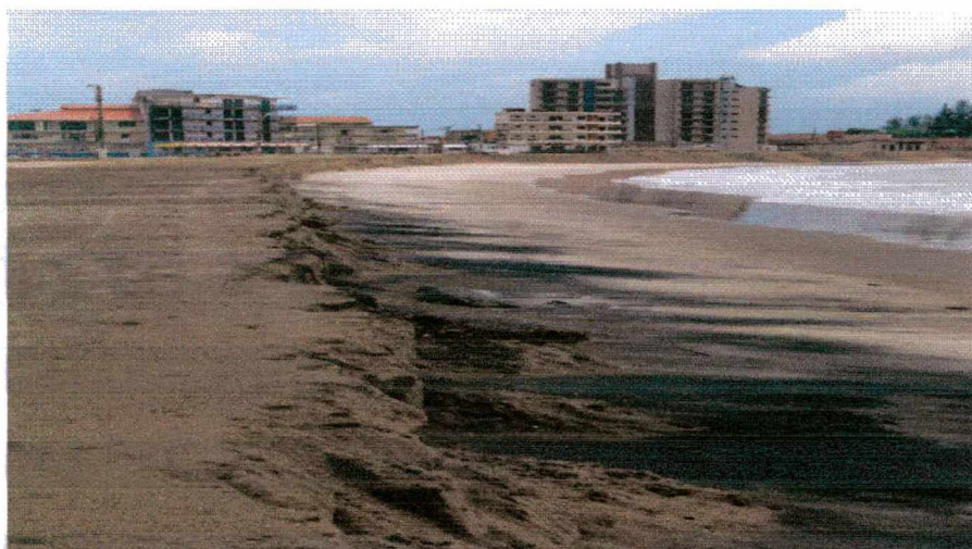
Figura 19 Fotografia orientada para norte mostrando a Praia do Gravatá após a alimentação realizada pela Prefeitura Municipal de Navegantes.
