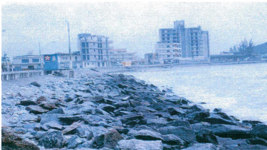
Figura 15 Fotografia orientada para norte mostrando os blocos de rocha colocados na praia de Gravatá para protege-la da ação da energia das ondas, 1996 (Foto: P.M.N.).
