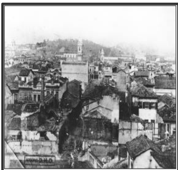
Fig.2 - Centro do Rio de Janeiro, início das obras de demolição, 1903. Arquivo Geral da Cidade do Rio de Janeiro
