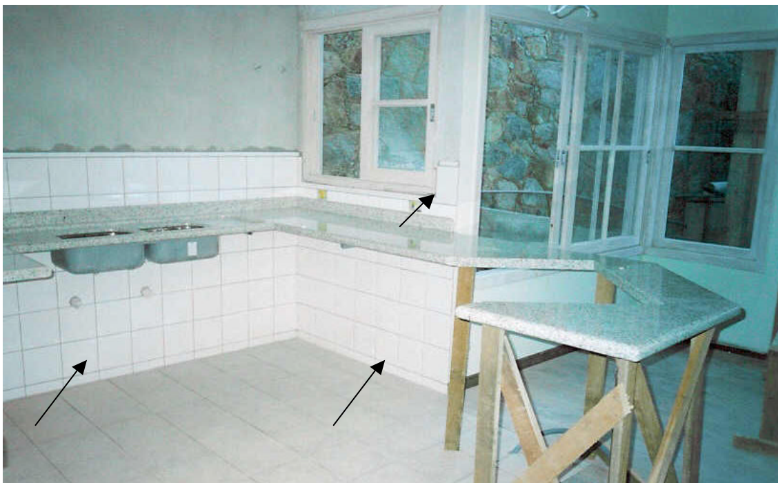
Figura 5 - Local da execução do revestimento cerâmico estudado
